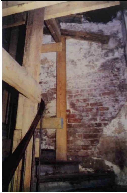
Photo 14 : vue du couloir d'un escalier étagé
