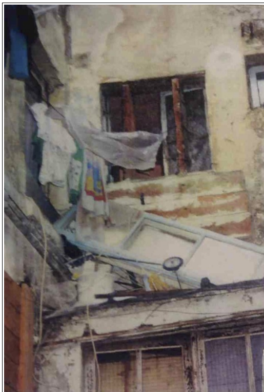
Photos 8 et 9 : deux autres vues de la cour intérieure
