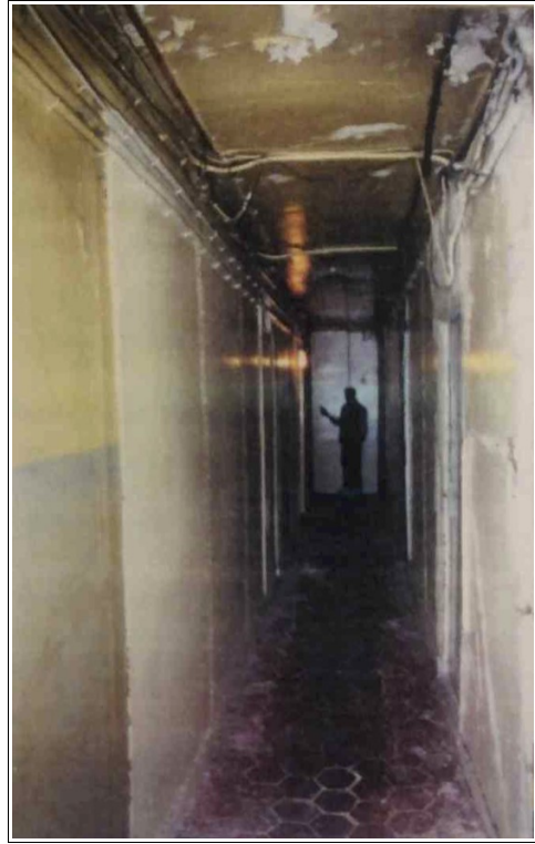
Photo 15 : vue d'un couloir
