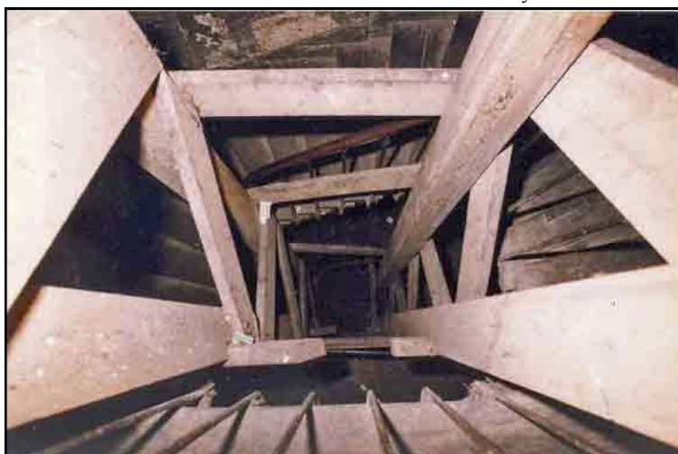
Photo 13 : vue aérienne d'un autre escalier étayé
