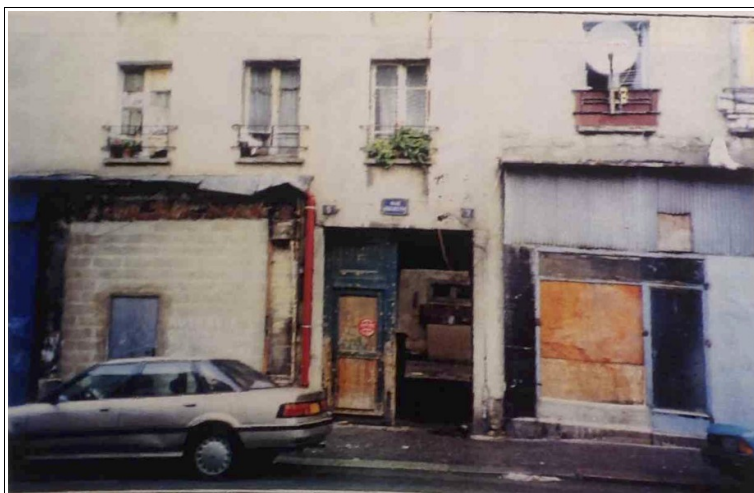
Photo 6 : vue de la rue, l'entrée du porche
