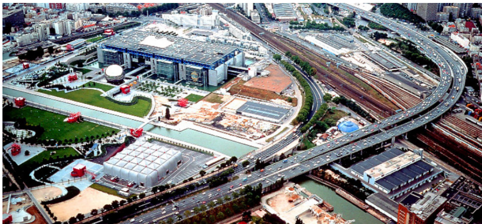
FIGURE 3 : ACCUMULATION D'INFRASTRUCTURES CRÉANT UNE VÉRITABLE COUPURE URBAINE
