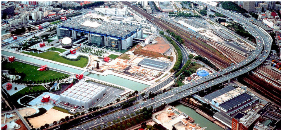
FIGURE 3 : ACCUMULATION D'INFRASTRUCTURES CRÉANT UNE VÉRITABLE COUPURE URBAINE
