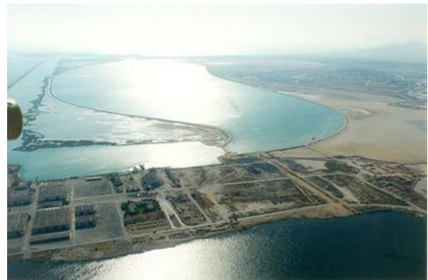
Figure 52 : Le Lac Nord après dépollution – Source : SPLT
