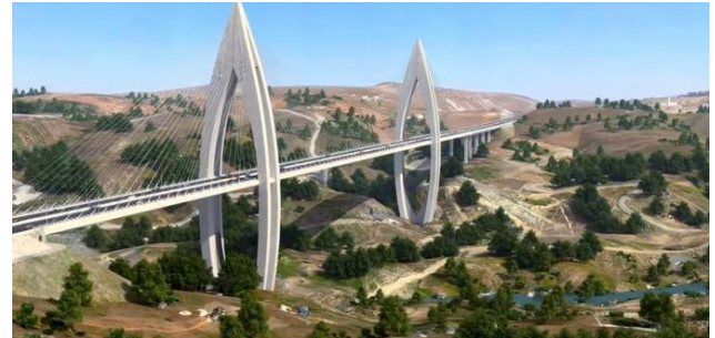
Figure 46 : Le pont reliant Rabat et Salé – Source : Wessal Bouregreg
