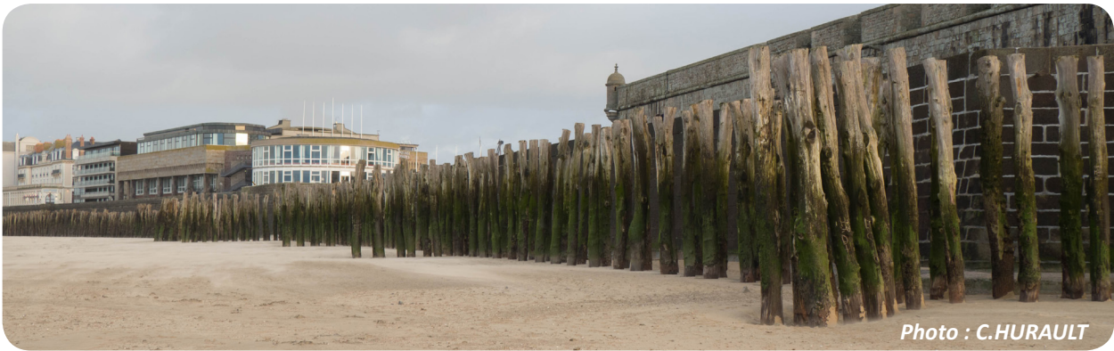
Photo 10 : Brise-lame sur la plage du Sillon à Saint-Malo
