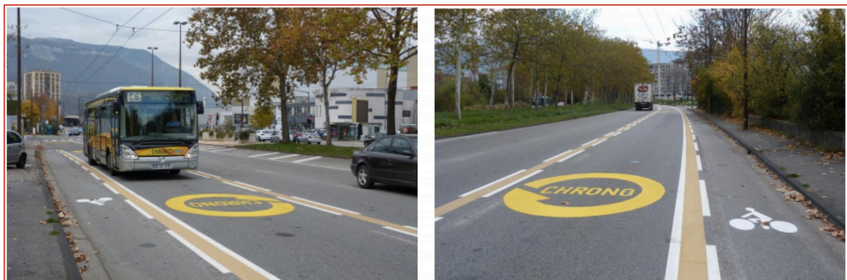
Figure 28. Mise en place progressive de sites propres (voies réservées) marqués du logo "Chrono" afin de renforcer l’identification du service dans le paysage urbain - SMTC
