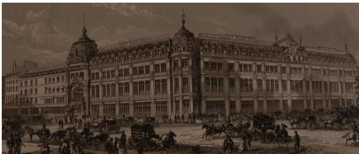
Vue extérieure des magasins du Bon Marché
