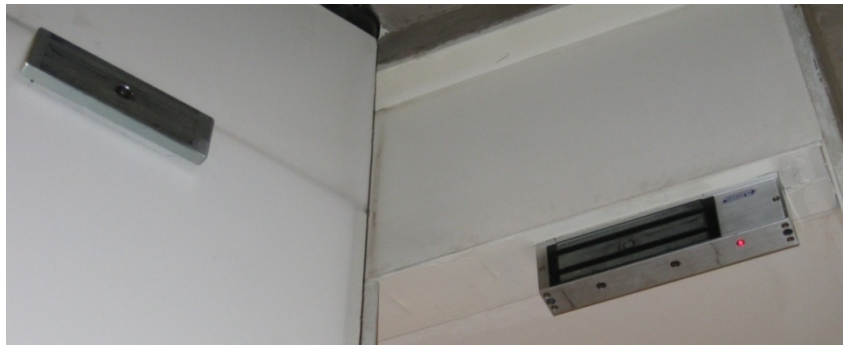
Figure 0.1 : Système de control d'accès par carte préconfigurées
