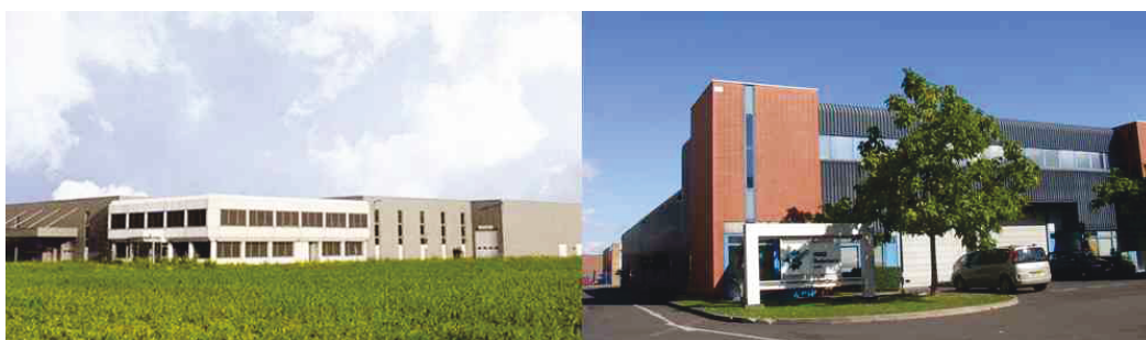
Vue de l'usine de Vieux-Thann et des locaux de Villepinte
