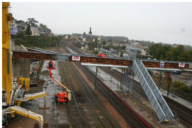
Passerelle en cours d'aménagement à Vitry
