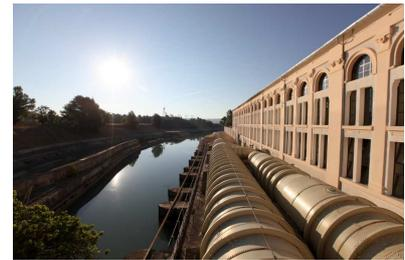
**Le canal EDF, artère énergétique de La Provence** : le long de ce canal EDF, 15 centrales hydroélectriques turbinent successivement l'eau pour la transformer en électricité. Outre la production d'électricité, il achemine l'eau sur le territoire, pour les besoins en eau : potable (1,5 million de clients), industrielle et agricole (irrigation de 150 000 hectares de terre).
