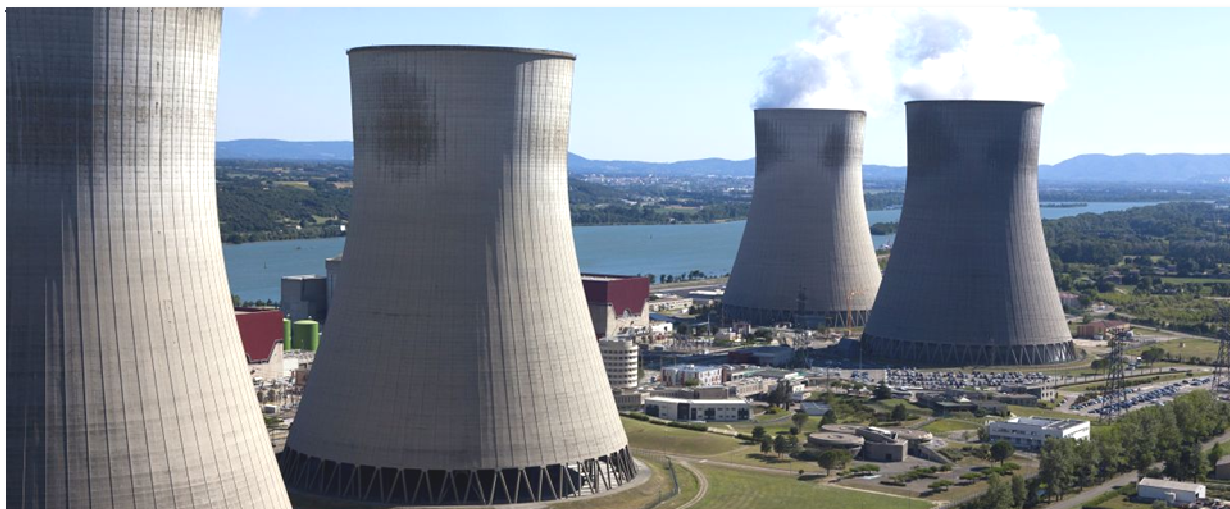
Fig. 5 - Vue aérienne du CNPE de Cruas-Meyssse
