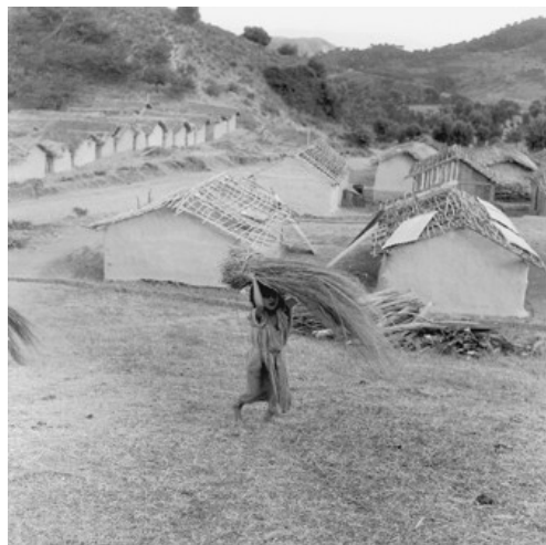
Fig. 47 Pierre Bourdieu, Cheraïa. Centre de regroupement en construction , photographie noire et blanc, v. 1960
