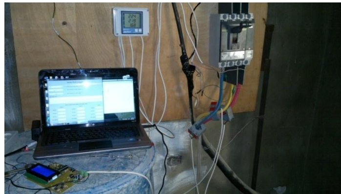
Figure III-8 : Installation de système de mesure sous service.
