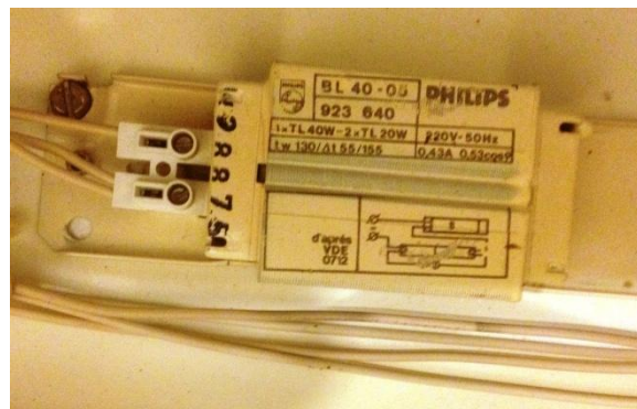
Figure IV-1 : la lampe TCS et sa bobine (ballast).
