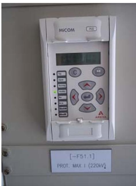
Figure 36- Relais de protection Max I 220 kV
