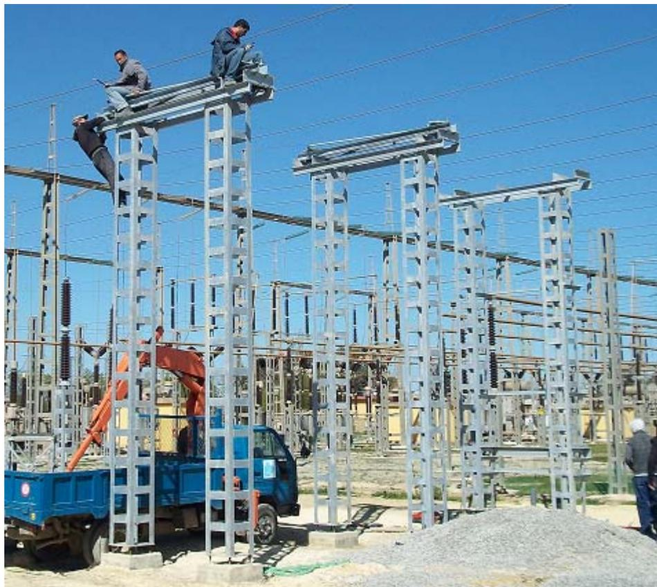
Figure 21- Montage charpente métallique SB pour la travée TR6
