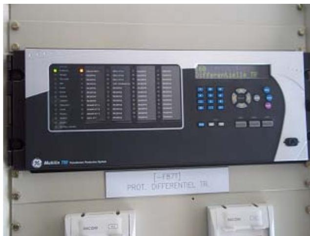
Figure 35- Relais de protection différentielle Transfo
