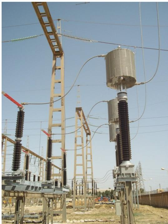
Figure 72-installation de CPL pour la travée ligne 220kV
