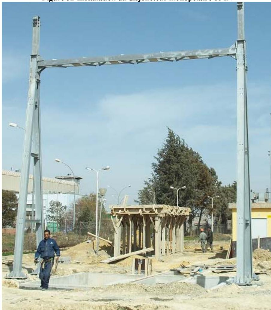
Figure 53-Installation de la charpente métallique au niveau du transformateur 60 kV
