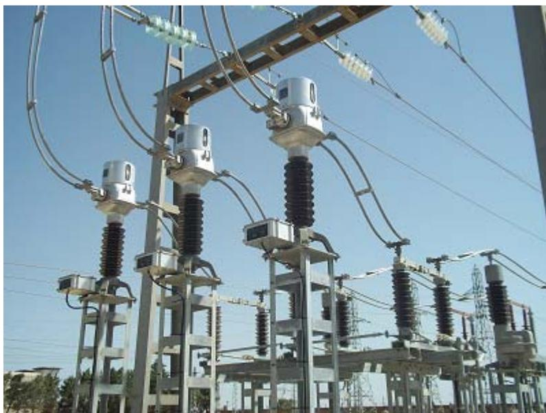
Figure 50-Installation des TC 60 kV de la travée ATR6
