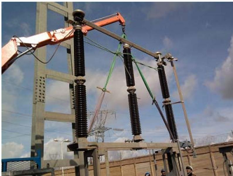
Figure 19-Démontage sectionneur ligne/ terre 220 kV
