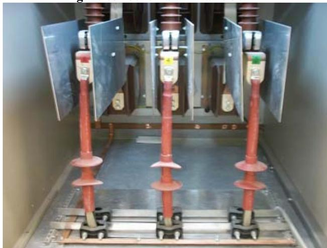
Figure 64- Installation des câbles 30kV à l'intérieur des cellules
