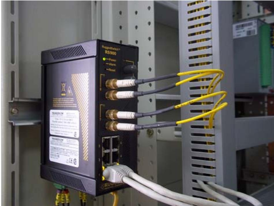
Figure 41- Installation des connecteurs fibre optique
