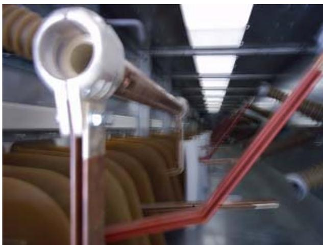
**Figure 60- JDB 30kV installé à l'intérieur des cellules MT**
