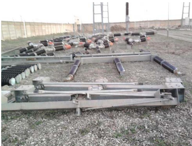
Figure 20- Une partie des équipements 220 kV démontée
