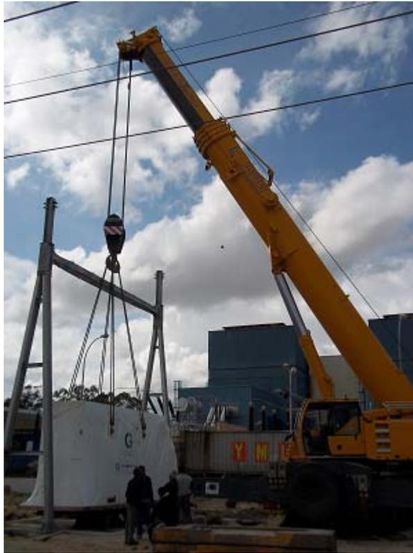
**Figure 54-** Mise en place de la cuve du transformateur 60 kV par une gue de 200 tonnes.
