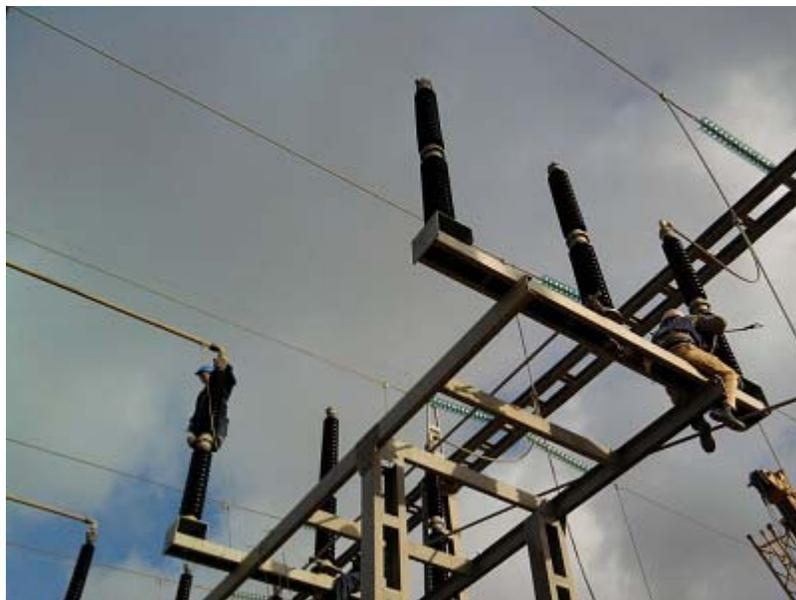
Figure 18- Démontage sectionneur barre 220 kV
