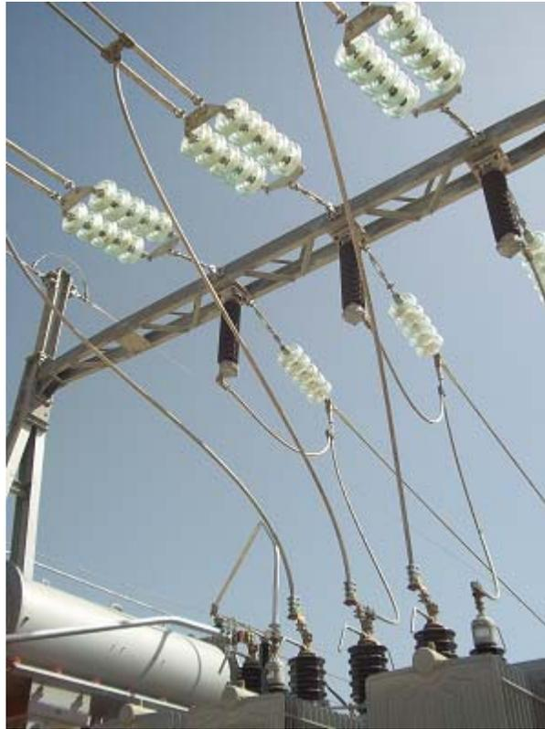
Figure 56-Installation des liaisons au niveau du TR60/30kV
