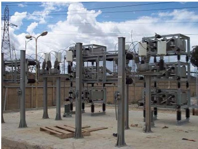
**Figure 59- Batteries de condensateurs**
