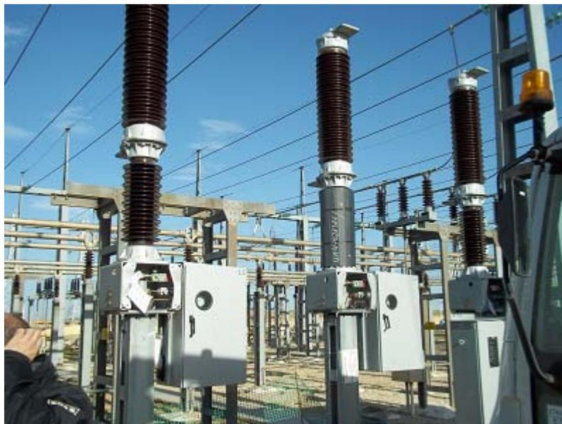
Figure 52-Installation du disjoncteur monopolaire 60 kV
