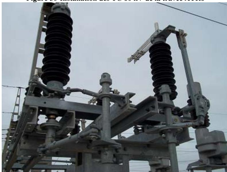
Figure 51-Installation d'un sectionneur ligne/terre 60kV
