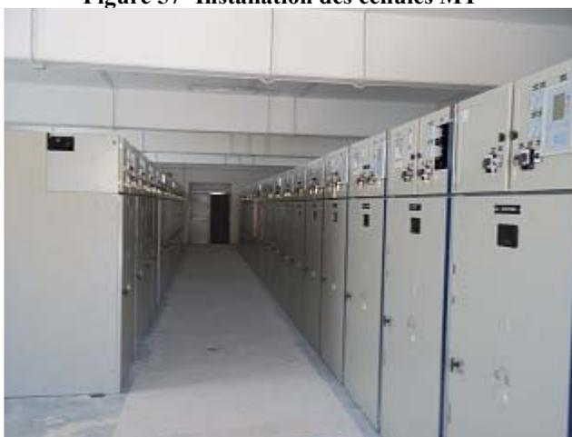
Figure 58- Installation des cellules MT
