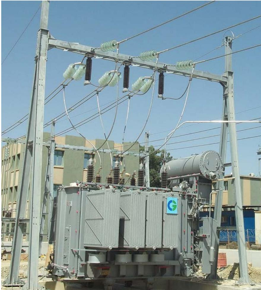
Figure 55- Le transformateur 60 / 30 kV après fin du montage.
