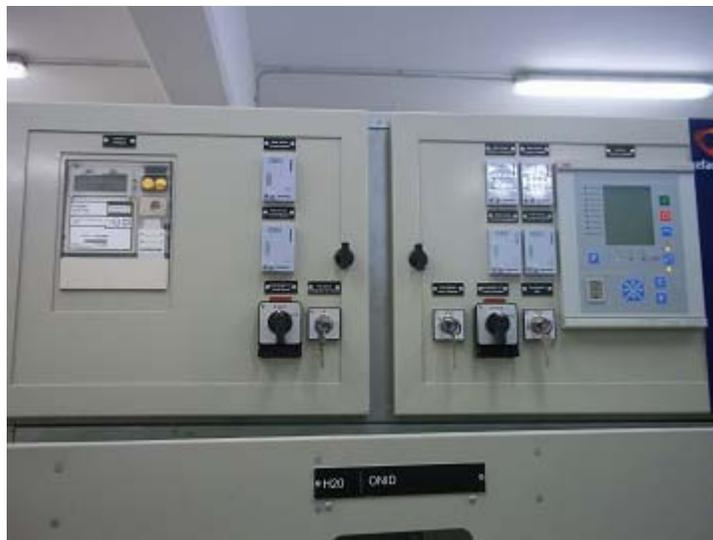
Figure 61- Tableau de contrôle d'une cellule départ (un relais de protection et un compteur)
