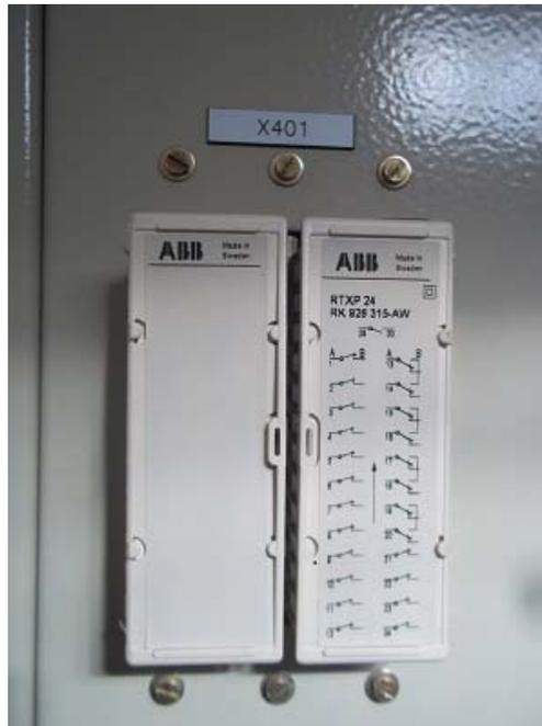
Figure 78- Boite d'injection ABB
