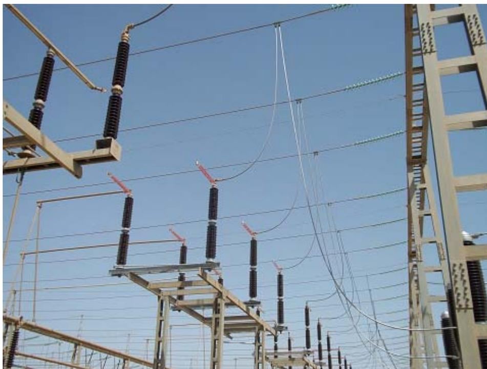
Figure 22- Installation du sectionneur JDB 220 kV de la travée ligne Tismilt
