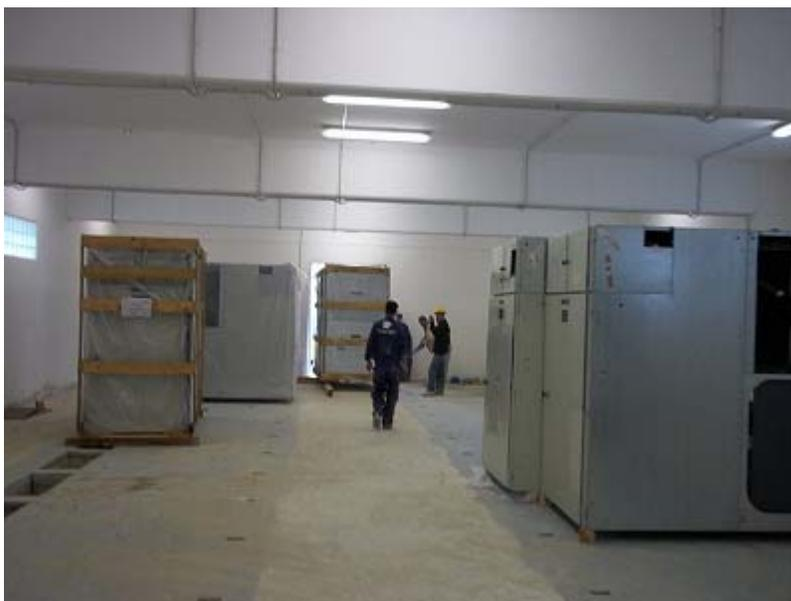
Figure 57- Installation des cellules MT
