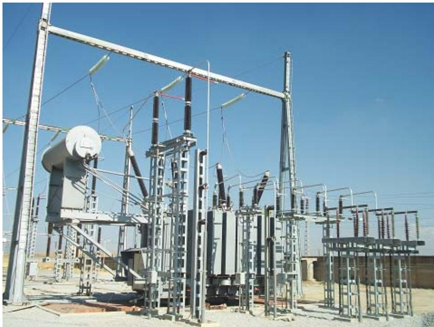
**Figure 26- Après la fin des travaux d'installations TR 220/60/10kV**
