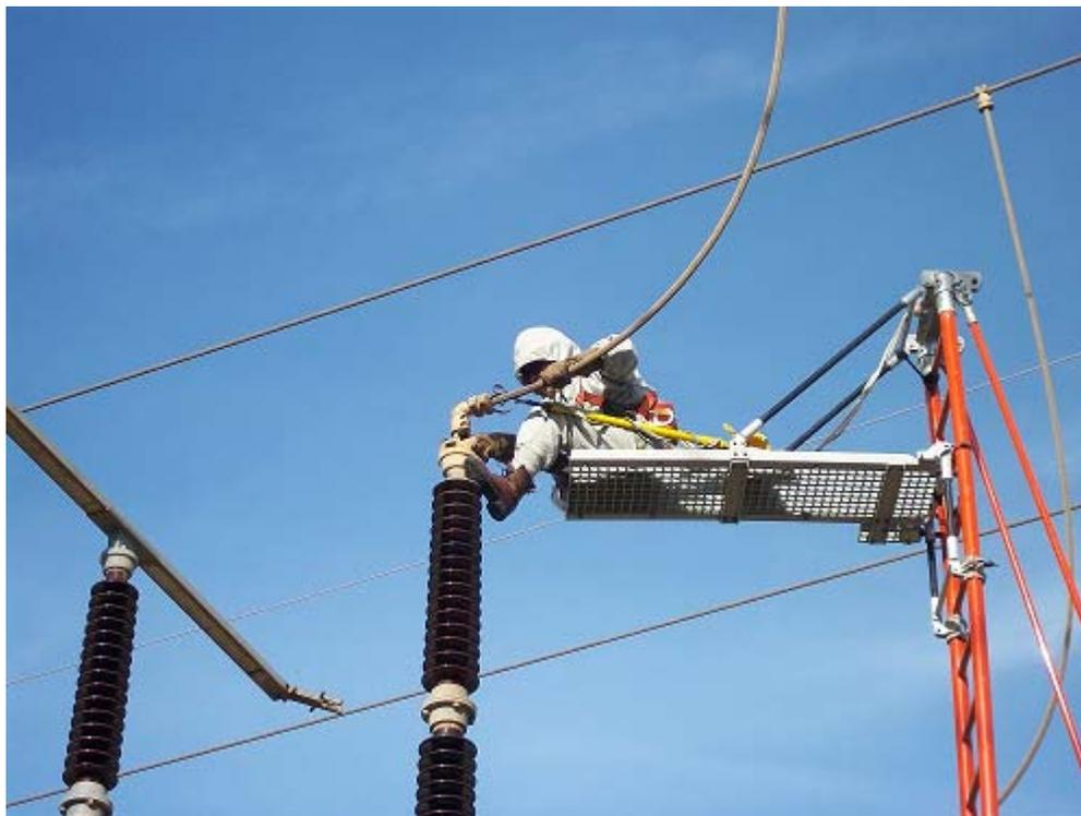
Figure 45- Travaux sous tension 220 kV
