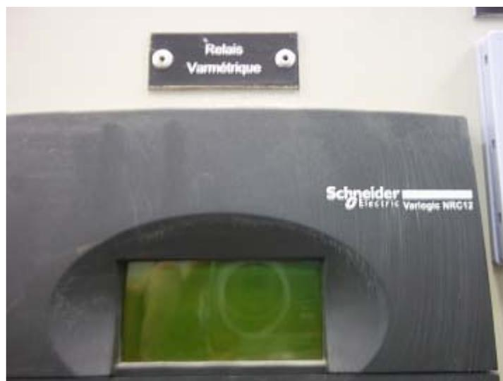
Figure 62- Relais varométrique
