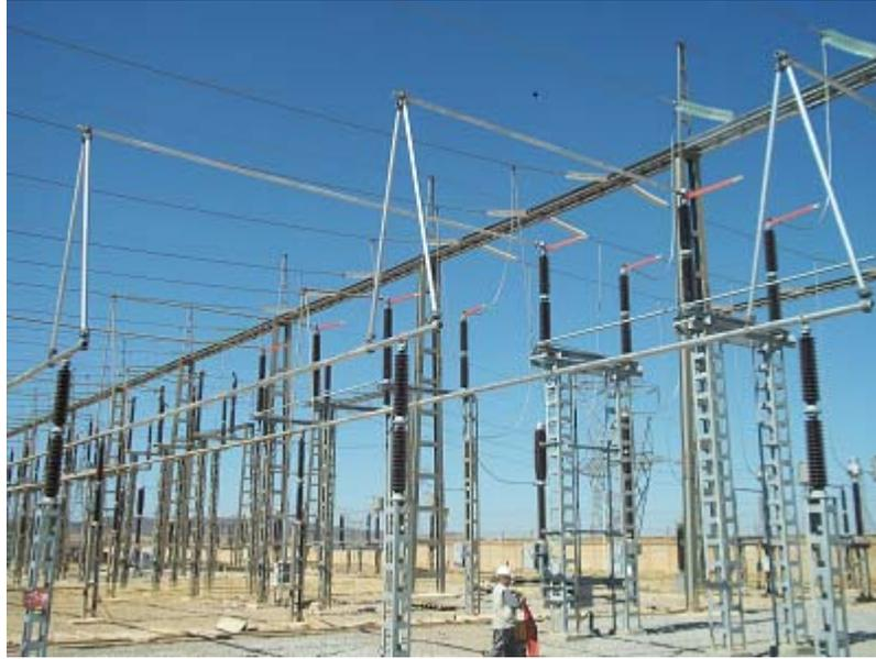
Figure 23- Après l'extension JDB et le montage des sectionneurs pour TR6
