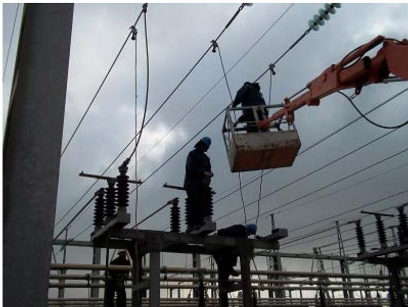
Figure 49- Démontage de la travée partiellement équipé
