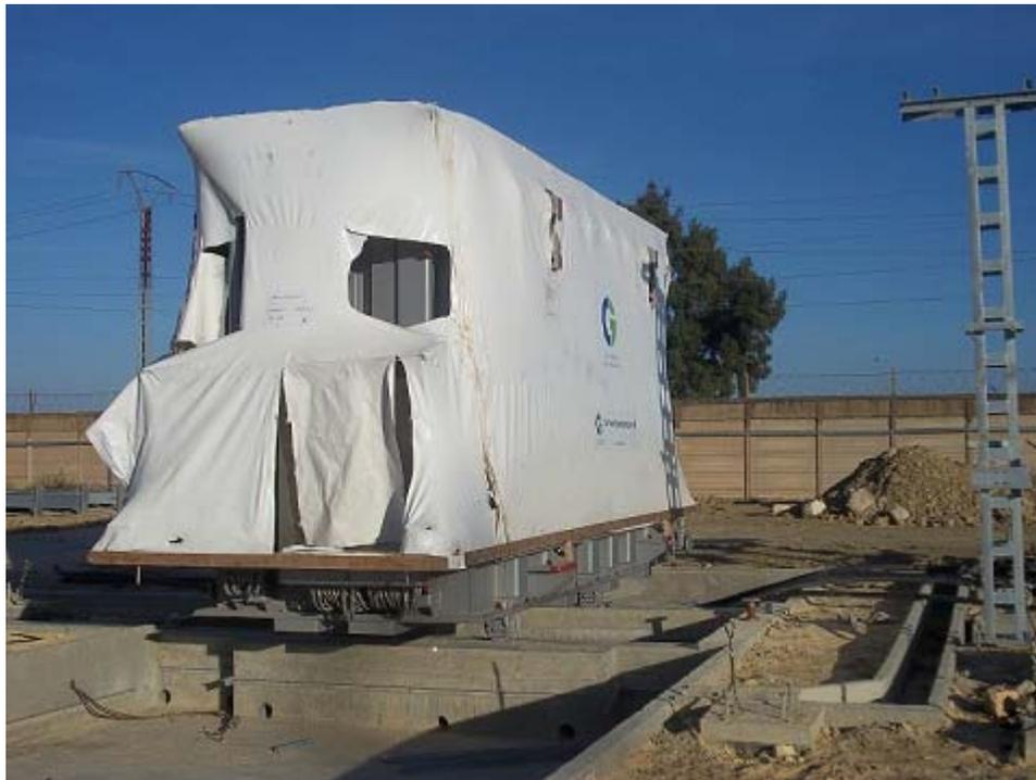
Figure 24- Le transformateur 220/60/10kV durant son arrivée au poste
