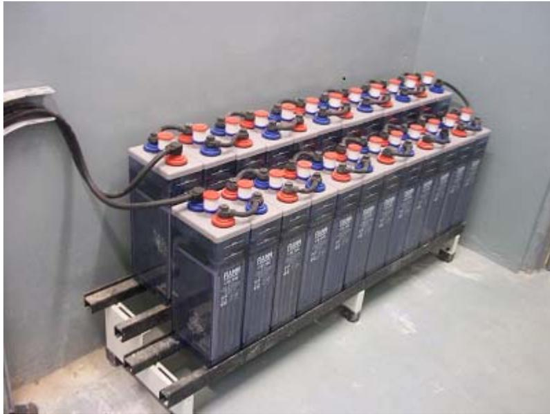
**Figure 67- Batterie 48 V**
