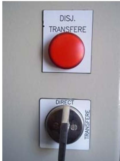
Figure 46- Commutateur pour disjoncteur de transfert.
