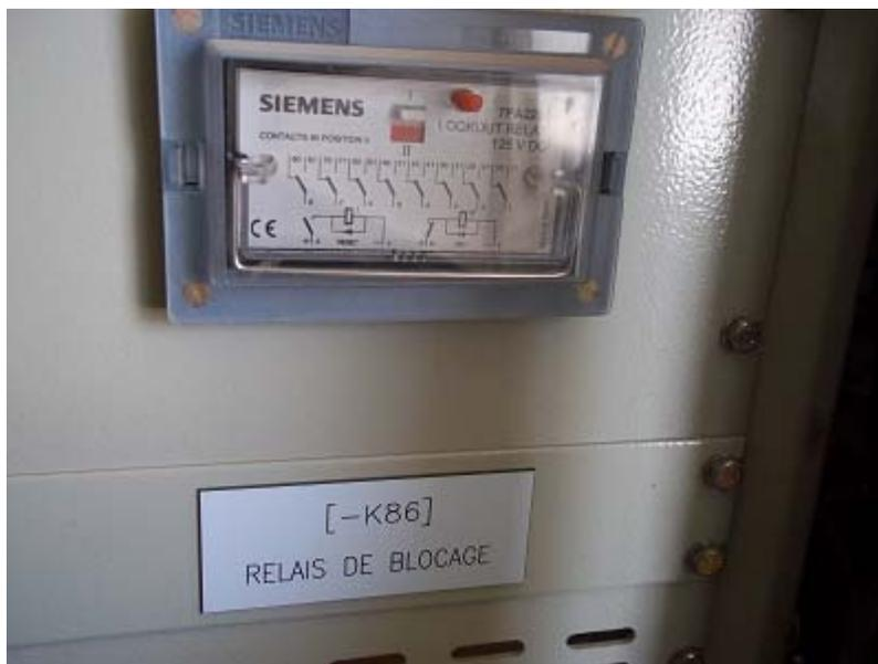
Figure 37- Relais de blocage K86
