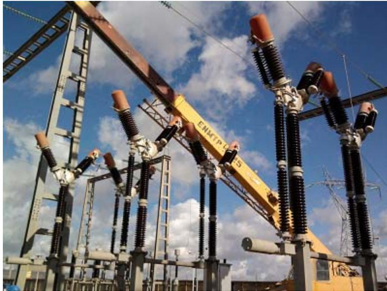
Figure 17- Disjoncteur 220 kV à démonter
