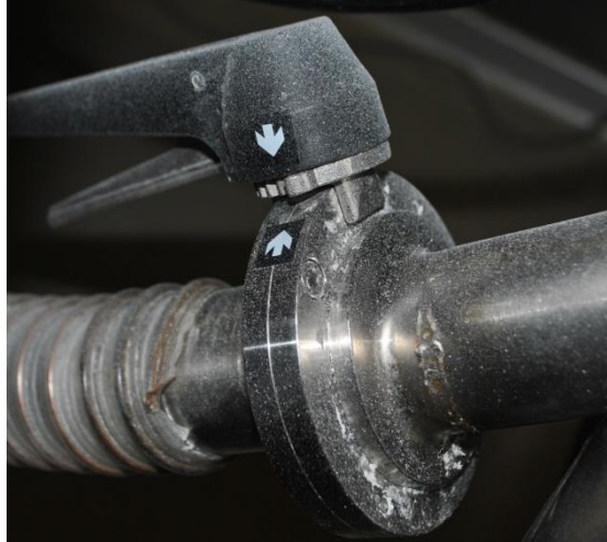
Figure 23 - Position conforme d'une vanne en compression
