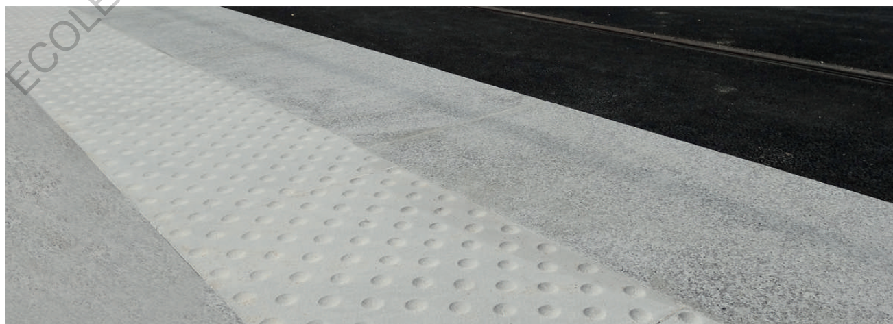
fig. 8 : Bande d'éveil au droit d'un quai de gare
