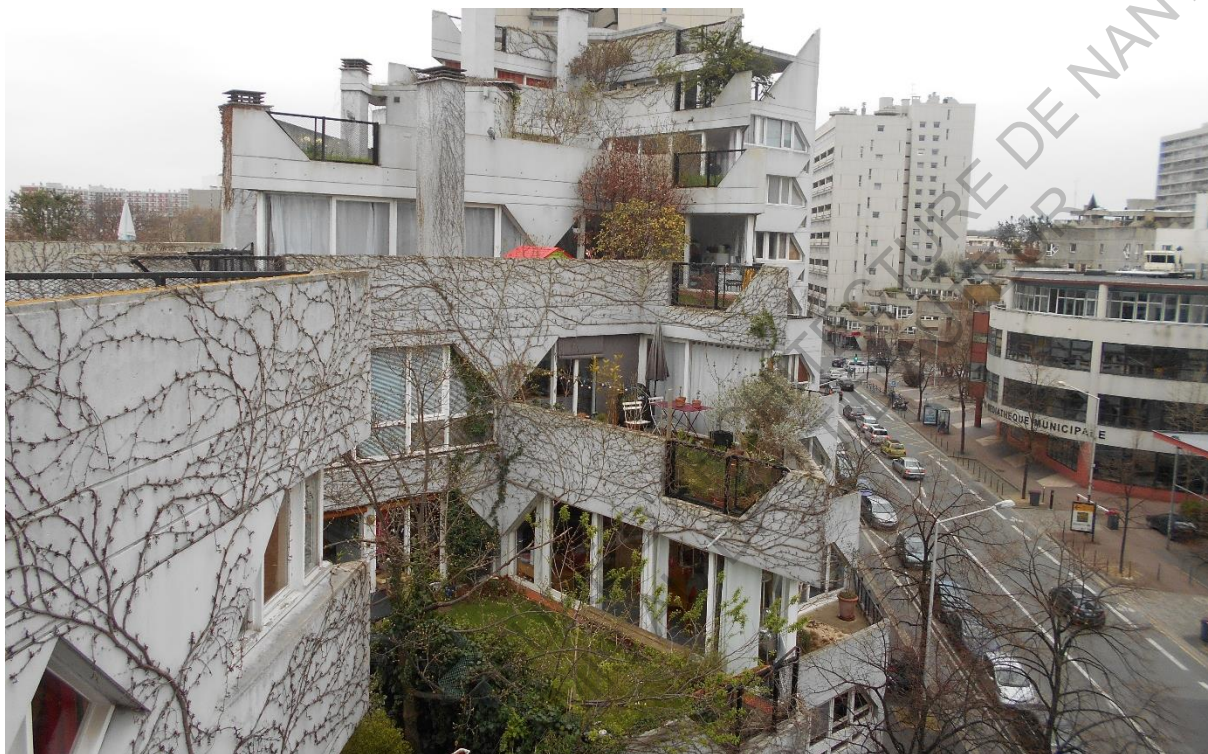
Photo de la végétalisation : un mauvais entretien des terrasses individuelles entraîne des problèmes d'étanchéité pour les voisins du dessous
