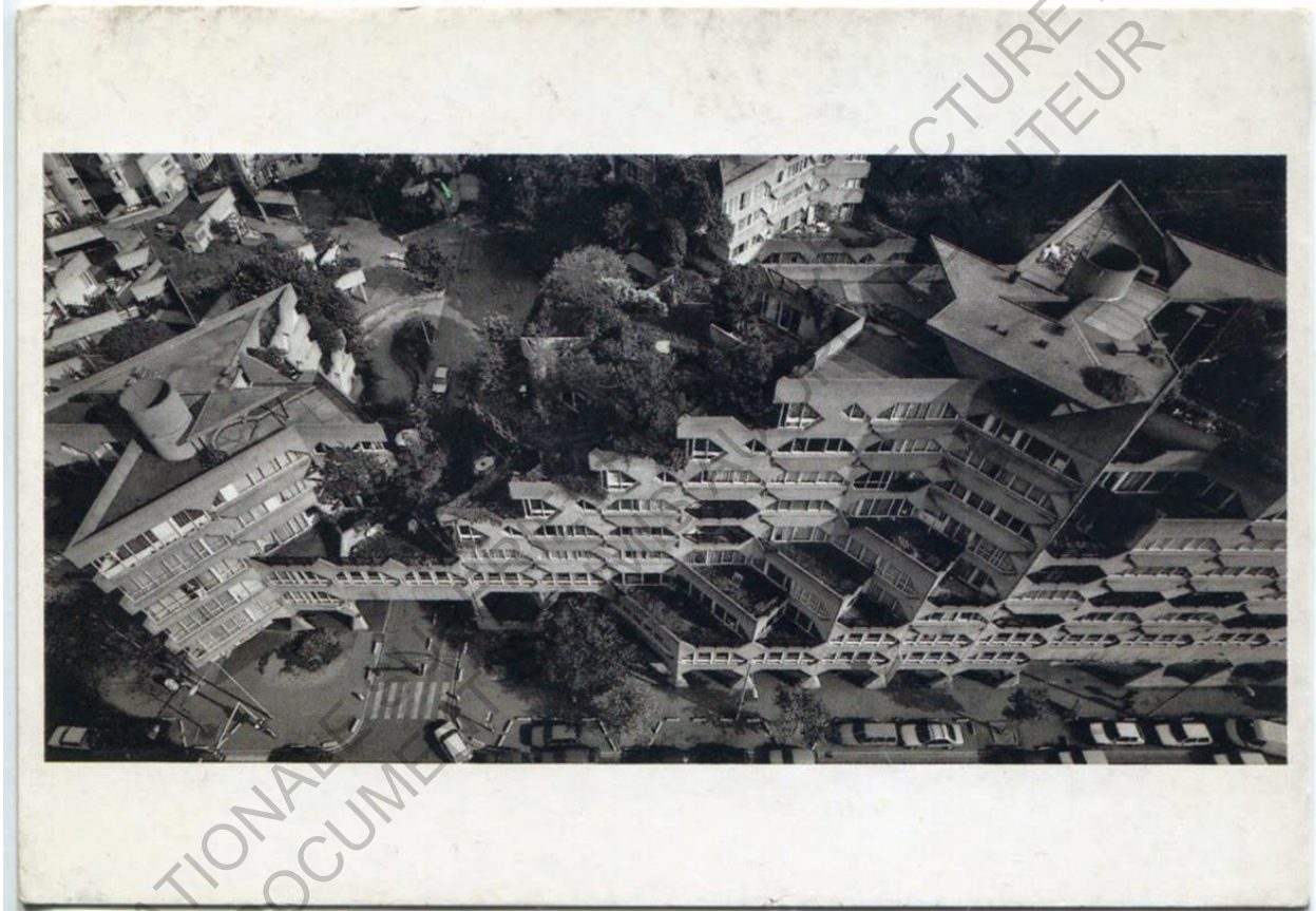
Photo aérienne de l'immeuble Casanova, Gabriele Basilico, 1992
