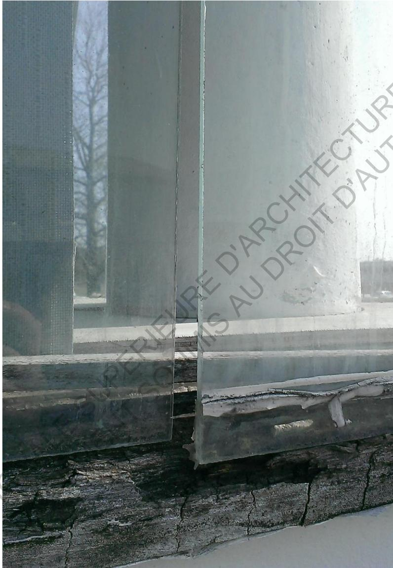
*Photo d'un joint extérieur : les vitres galbées réduisent l'étanchéité à l'air du bâtiment - ici un espace de coin aigu*
