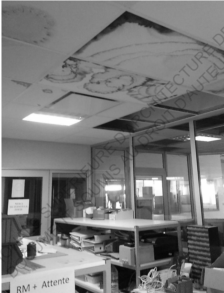
*Photo des auréoles jaunes provoquées par une mauvaise isolation thermique*
