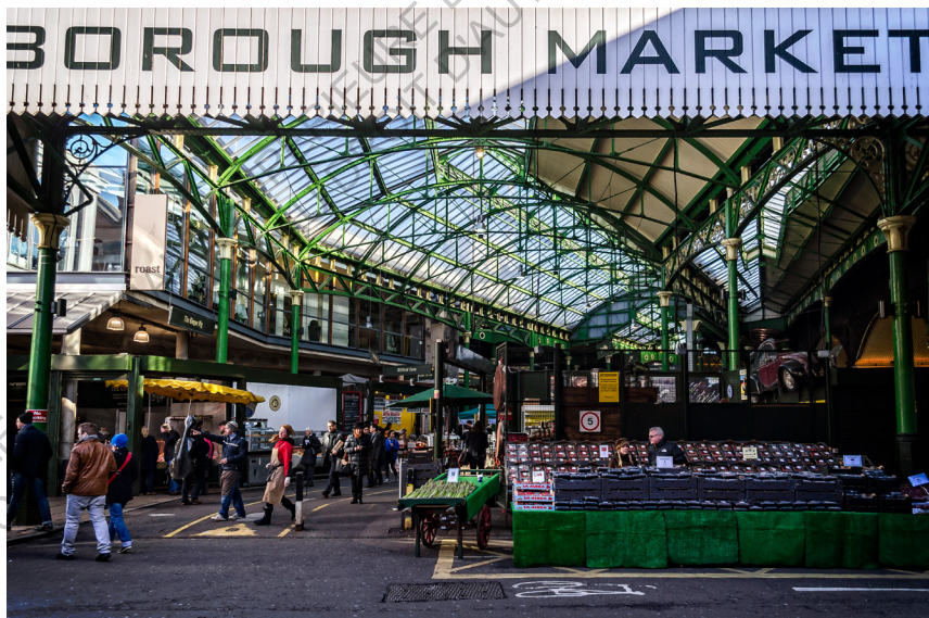
Fig 43 & 44 - Le viaduc et les infrastructures surplombant le marché. Une vue actuelle du marché
