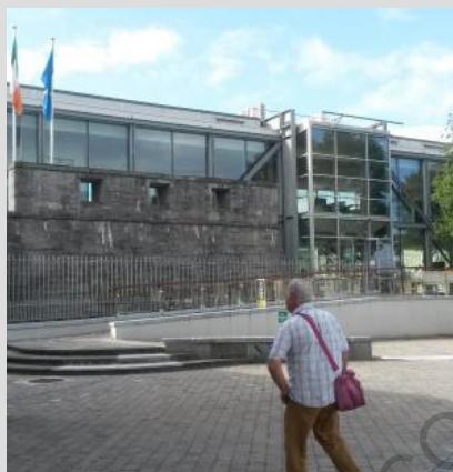
Fig. 120 - Façade sur rue du musée
