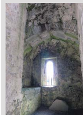
Fig. 76 - Entrée du château comblée
