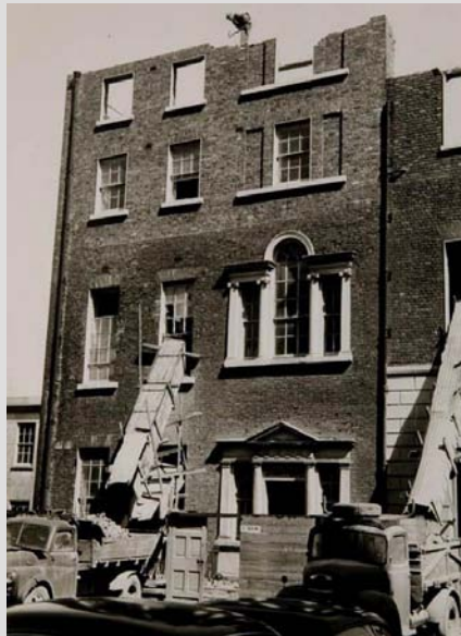
Fig. 40 - Démolitions sur Kildare Street, Dublin
