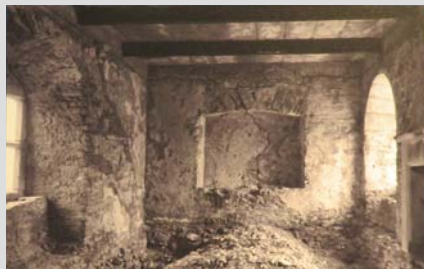
Fig. 100 - Avant restauration, plafond en béton
