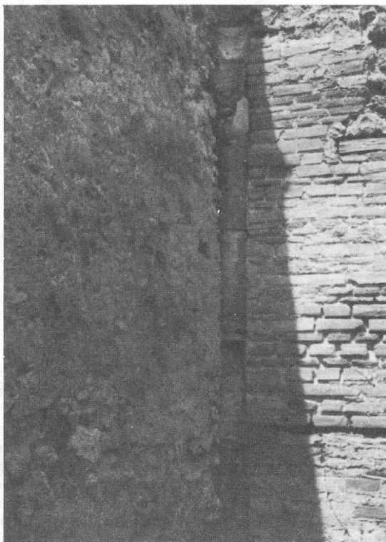
Fig. 32 : cheminée encastrée placée dans le coin de la pièce, Pompéi (Degbomont 1984, 152).
