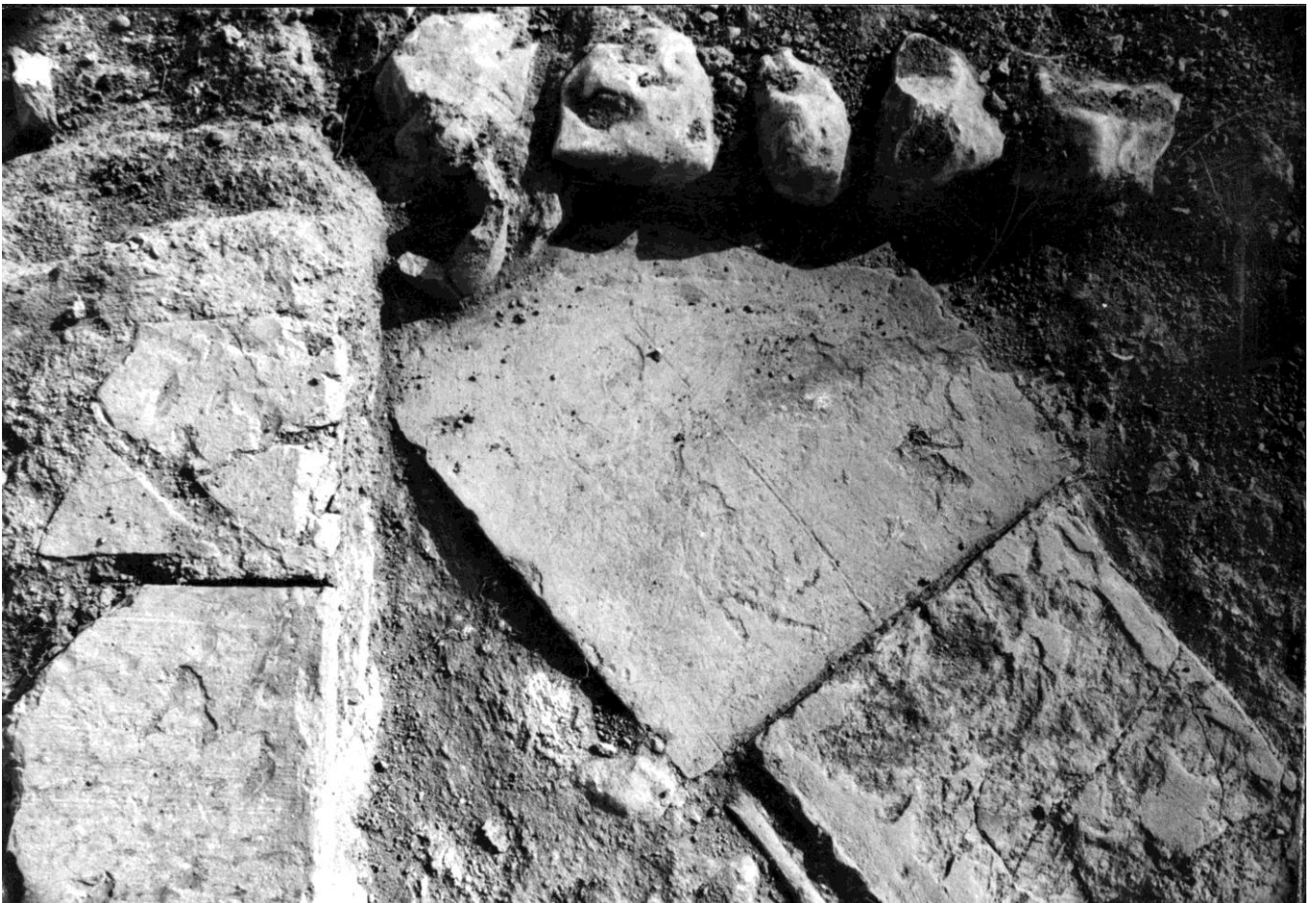
Annexe 70 : Détail de l'évacuation d'air située à l'extrémité de la canalisation, dans l'angle nord-est (Lauffray, J.69(15).68 et I.42(28).67).
