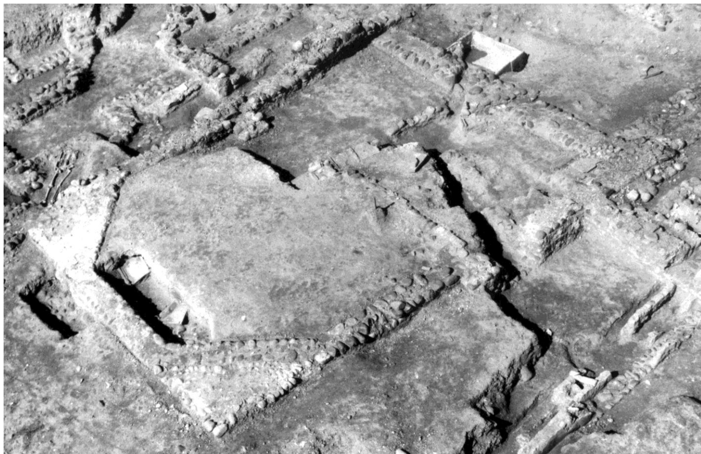
Annexe 60 : Vue d'ensemble du chauffage XII (Lauffray, J.55(21).67).
