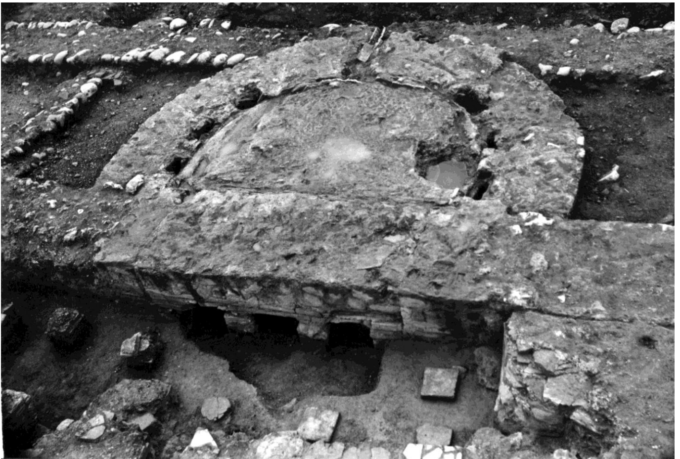
Annexe 20 : Vue générale de l' alveus nord. (Lauffray, G.49(27).67).
