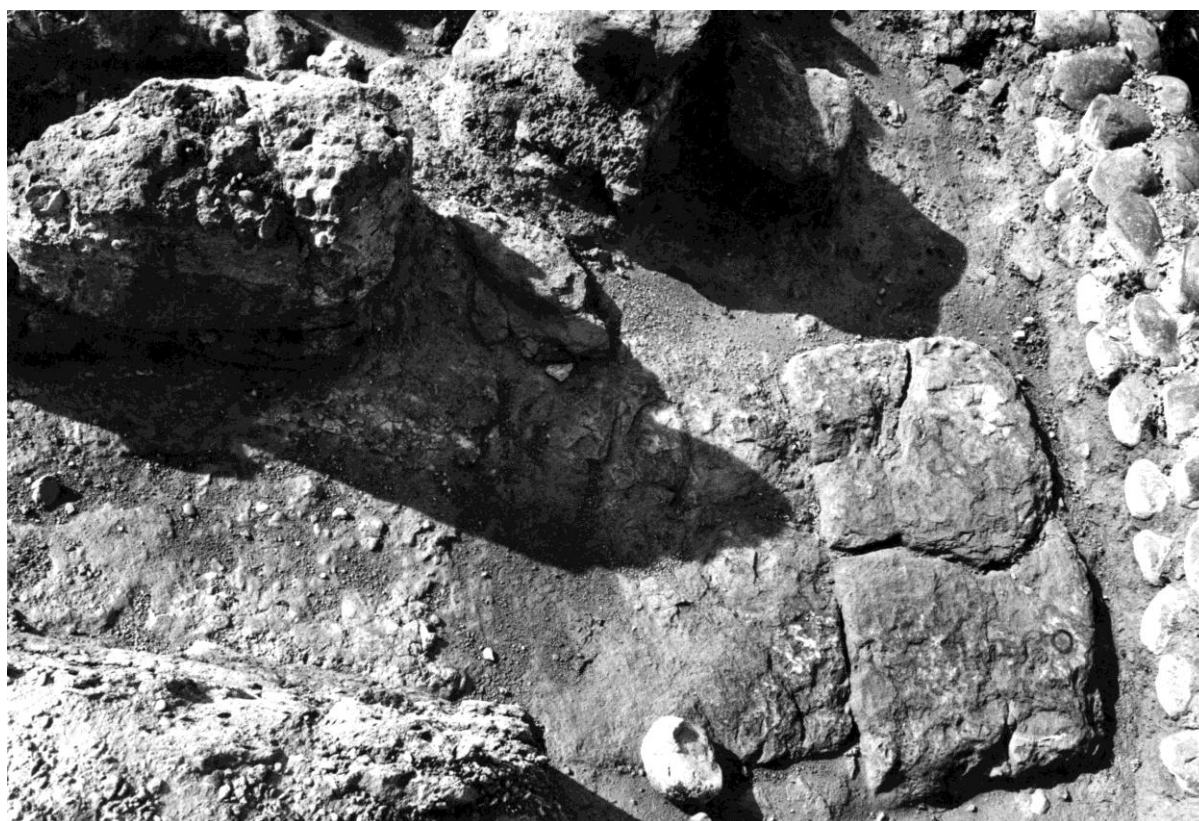
Annexe 28 : Détail de la salle de chauffe montrant les deux pierres en gré encadrant le foyer et la sole. (Lauffray, M.3(17).70)
