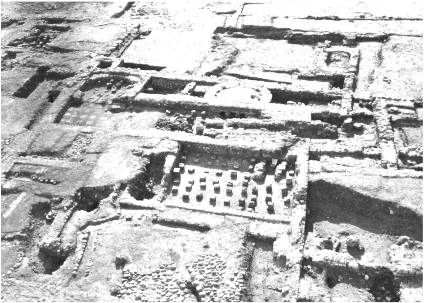
Annexe 33 : Vue d'ensemble de la salle V. (Lauffray, A93 43).
