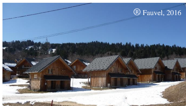
Photo 4 : Les chalets de location à La Féclaz
