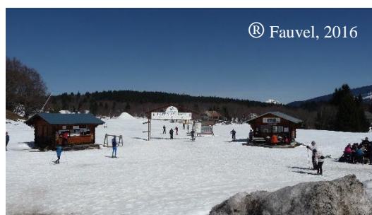
Photo 6 : Le chalet pour l'achat des forfaits (à gauche) et le chalet de fartage (à droite) au niveau de La Porte de La Féclaz
