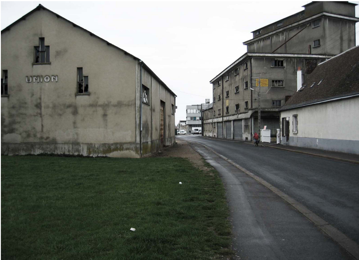
Anonyme, emplacement du nouveau cinéma, quartier en friche proche des voies ferrées, service de l'urbanisme et de l'aménagement, rue Darreau, Vendôme, date inconnue (avant 2009).
