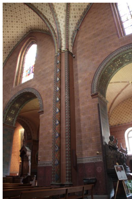
Pilier central sud
