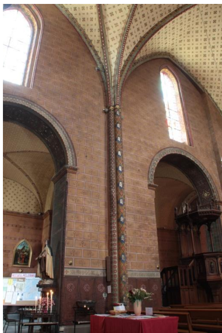
Pilier central nord
