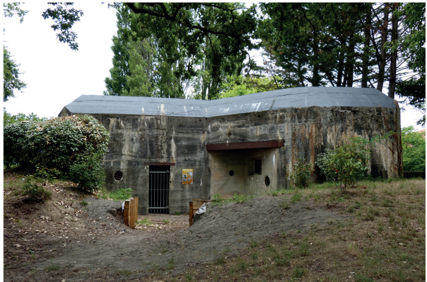
Entrée du blockhaus anti-char de type 506d
