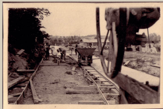
Construction de pistes en béton au Vigan Collection particulière
