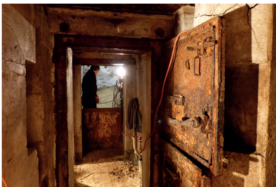
Dégagement du sable dans les sas d'entrée
