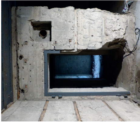
Encadrement de porte blindée dans la salle de vie (A.Chaigneau)
