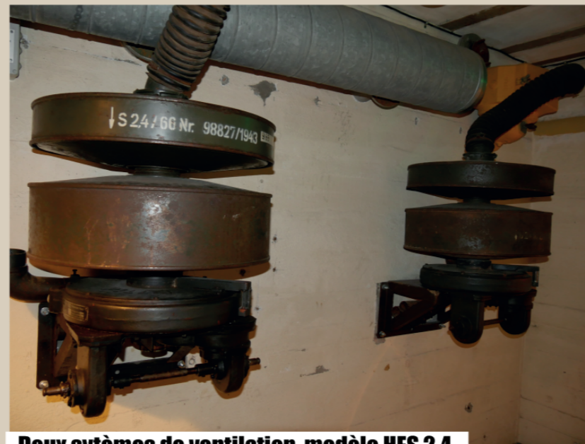
Deux systèmes de ventilation, modèle HES 2.4 Musée Le Bunker - La Rochelle (17) Deux systèmes de ventilation, modèle HES 2.4
