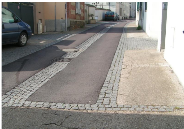
Figure 15 Rue du Belvédère – Source personnelle
