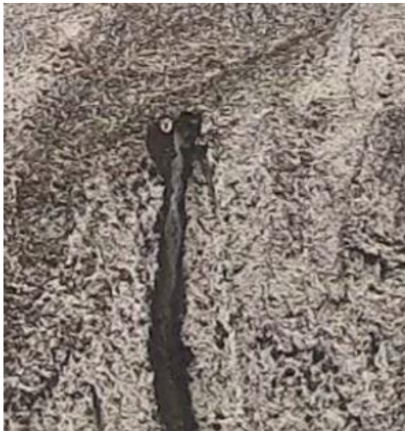
Figure 26 : Glissement au niveau d'une resurgence, les débits d'eau sont encore importants au lendemain des évènements (Source : PGHM)
