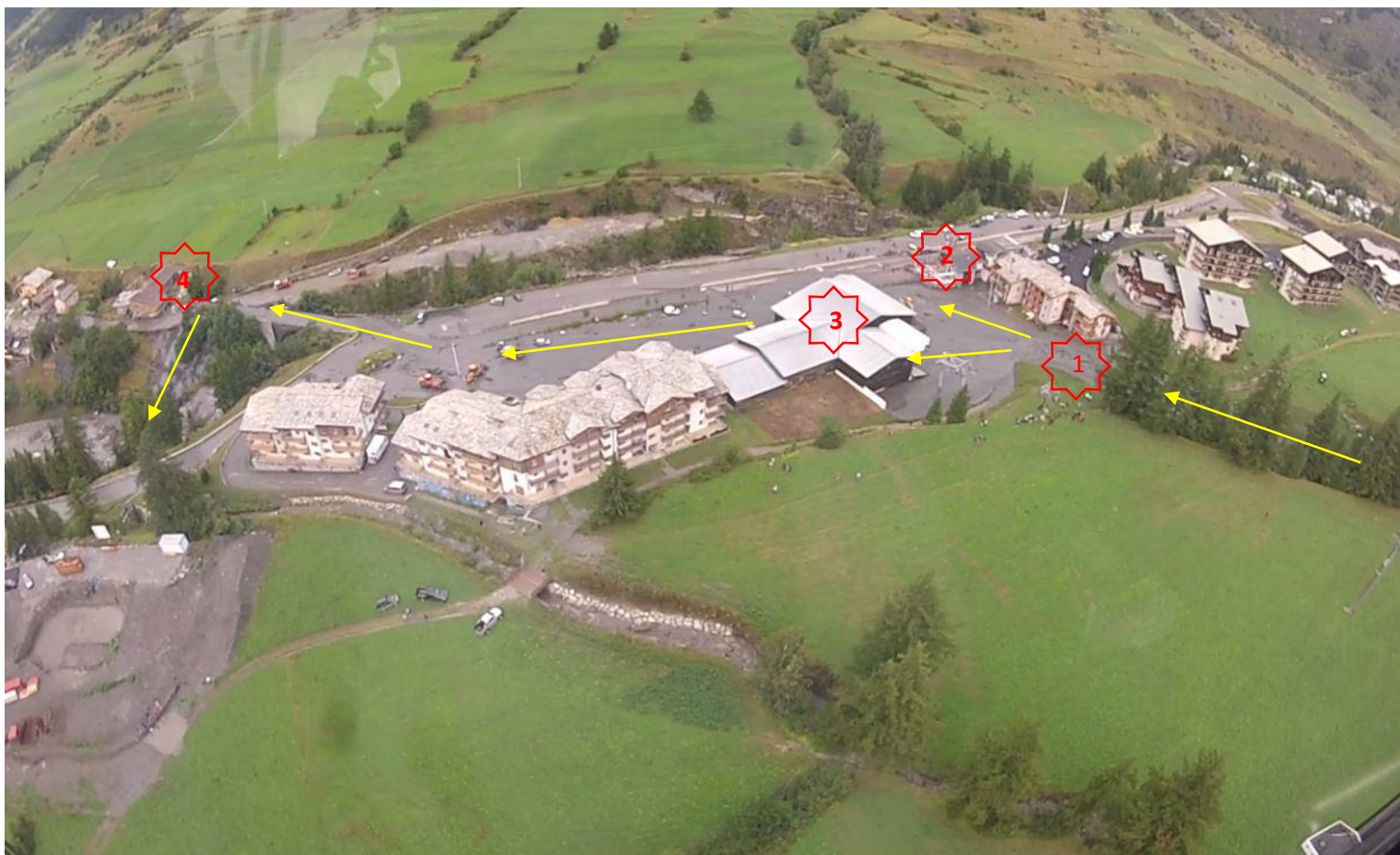
Figure 28 : Schéma retraçant le trajet et les dégâts des débordements de la lave torrentielle au niveau de Lanslevillard. 1 : passage busé obstrué à l'origine des débordements. 2 : Cave de restaurant impactée par les débordements. 3 : Bâtiments de la SEM de Val Cenis et gare de départ du télésiège du vieux moulin traversés par les débordements. 4 : Ecoulement redirigé dans l'ARC par un merlon temporaire construit à la pelle mécanique avant d'atteindre le lieu-dit « les Champs ». (Source : PGHM)
