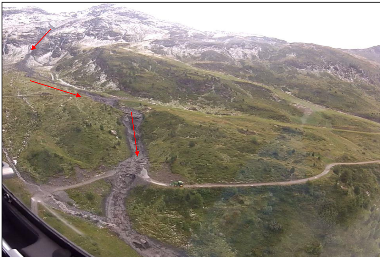
Figure 27 : Sur cette photo prise le lendemain des évènements, nous pouvons distinguer le cheminement de la lave torrentielle des ravines jusqu'à l'entrée des gorges. (Source : PGHM)
