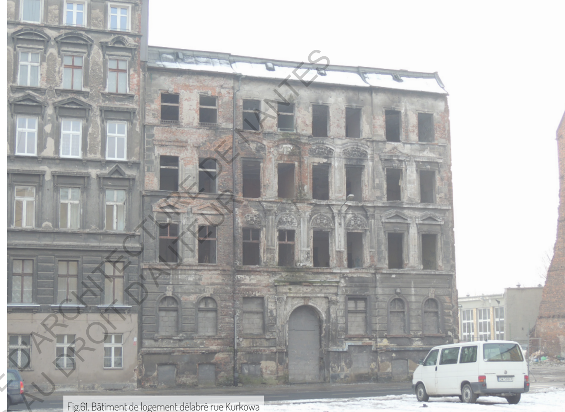
Fig.61. Bâtiment de logement délabré rue Kurkowa
