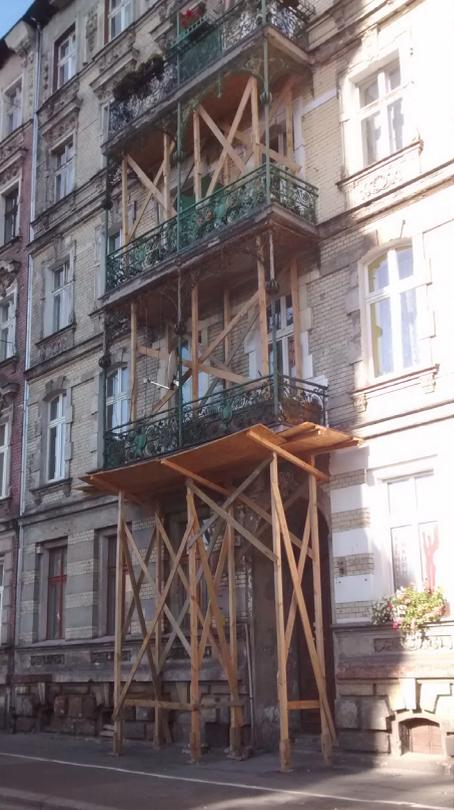
Fig.1 balcons soutenus par des échafaudages, Wrocław
