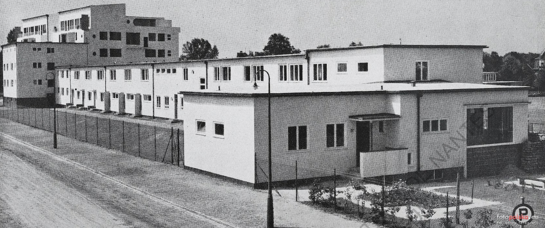
fig.12 Ensemble des bâtiments n°9 (arrière plan) à 22 en 1929
