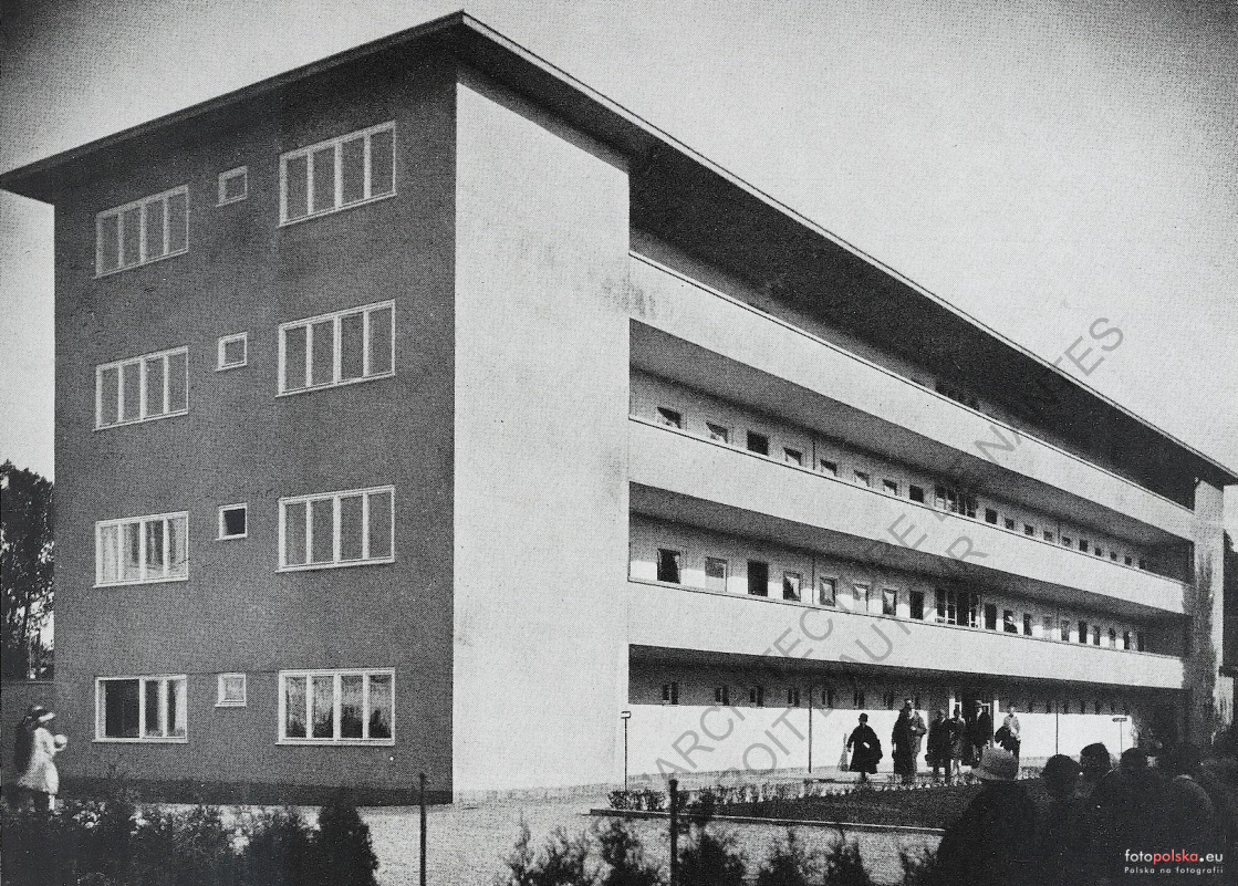
fig.10 Bâtiment coursive de P.Heim et A.Kempler en 1929, bâtiment n°2
