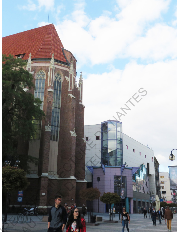
Fig.2 rue Świdnicka, Wrocław
