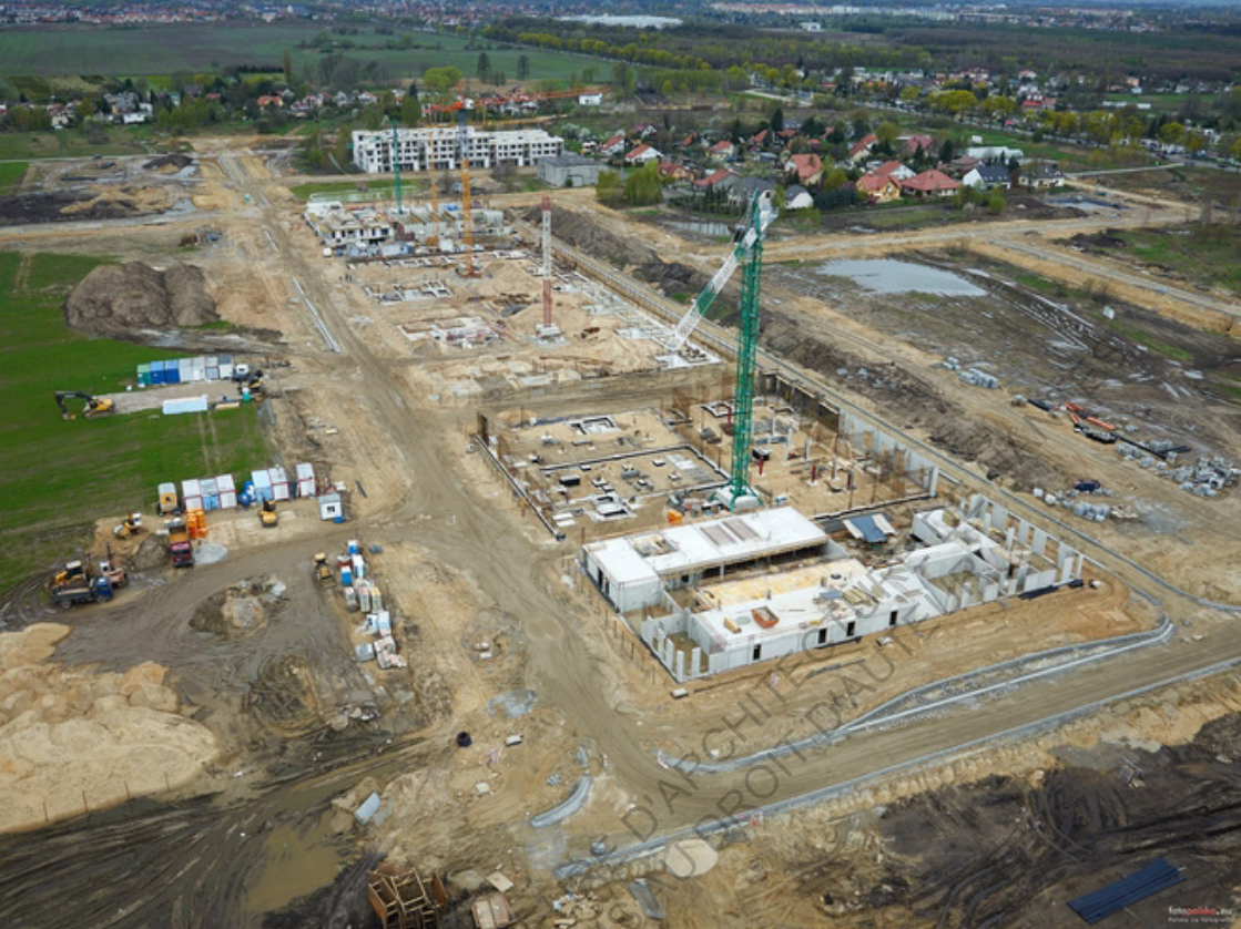
fig.33 Le projet WUWA 2 en construction sur un terrain en périphérie de la ville de Wrocław
