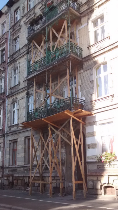
Fig.1 balcons soutenus par des échafaudages, Wrocław
