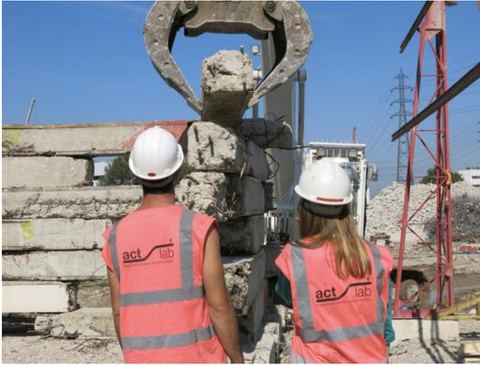
Dépose de poutres en béton sur le site de ActLab
