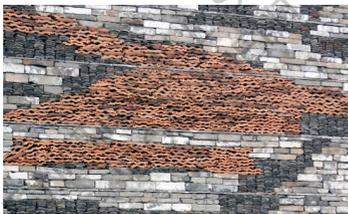
*Technique traditionnelle chinoise, le wa-pan consiste initialement à réparer un mur percé avec des petites briques et des tuiles empilées. De réparation, on peut passer au parement voir même dallage ou couverture. C'est un travail qui demande expérimentation et tests sur les chantiers.*
