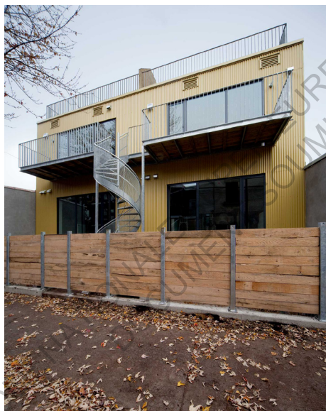
Fig 36 et 37. Façade principale et secondaire de la résidence Cartier par l'agence Nature Humaine Architecture
