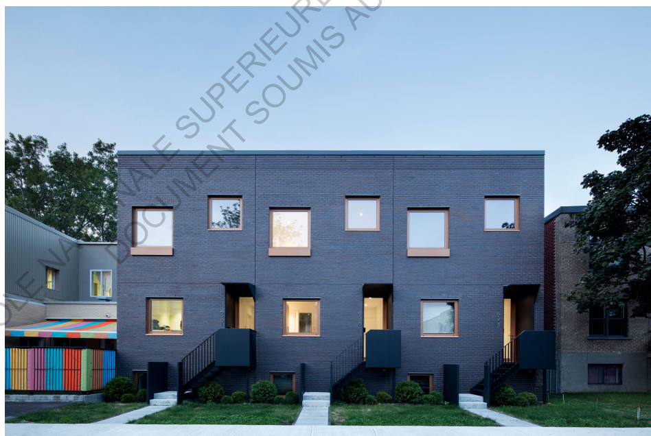
Fig 33. Façade principale de la résidence Marquette par l'agence Nature Humaine Architecture
