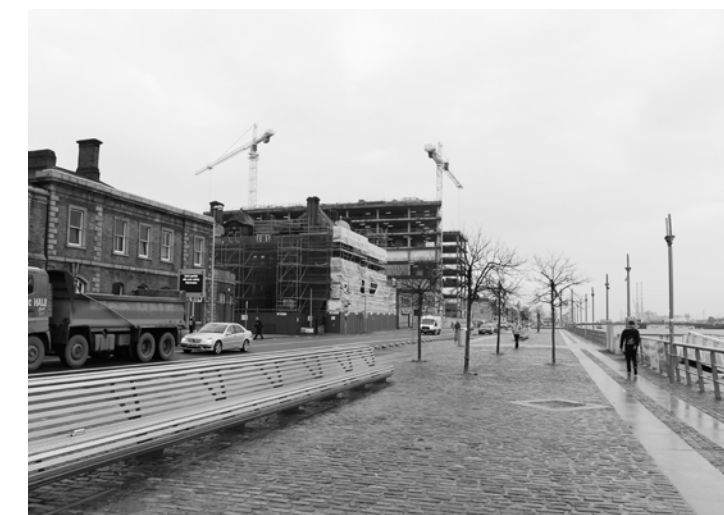
Le Custom House Quay ▶ aménagé pour les piétons et cyclistes, 2016
