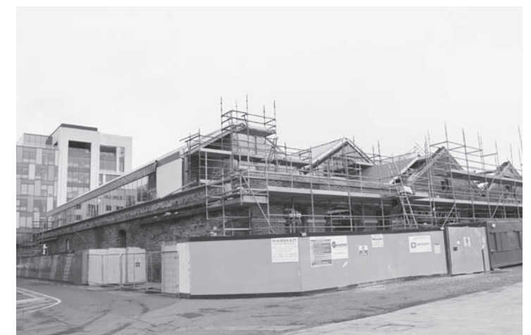
▶ Réhabilitation en cours au 8, Hanover Quay pour le nouveau siège social de Airbnb par RKD architects
