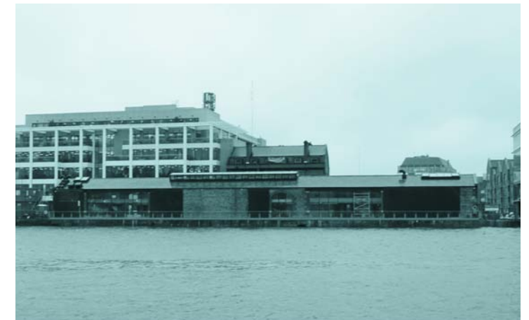
▶ Entrepôt en cours de réhabilitation à Sir Rogerson's Quay par les architectes Lawrence and Long
