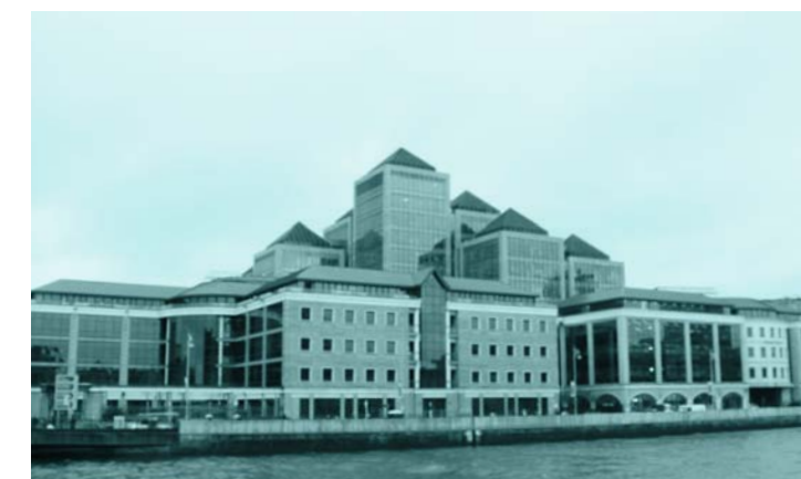
Immeubles de la Ulster Bank, George's Quay, quartier de Pearse Street
