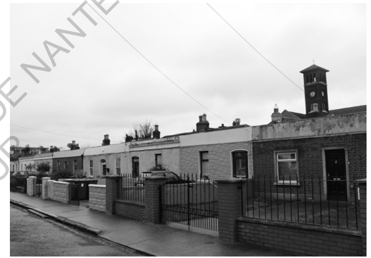
Habitations ouvrières à Hawthorn Terrace ▶
