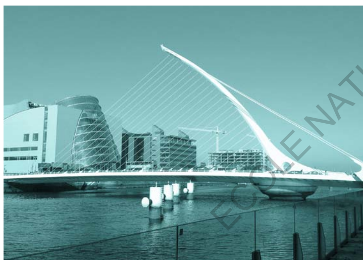
◀ Samuel Beckett Bridge, par l'architecte Santiago Calatrava. Pour les piétons, cyclistes, automobilistes et transports en communs
