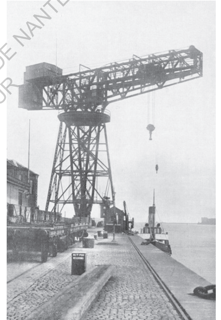
1926, Grue électrique lors de la construction de North Wall
