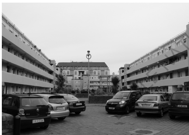
◀ Gated community à Hanover Street (Pearse street). Ensemble architectural clos et auto-surveillance développée. L'étranger est vite repéré
