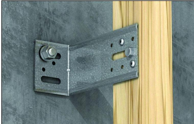
**Figure 13: Montant rapporté sur la structure support avec une patte équerre**
