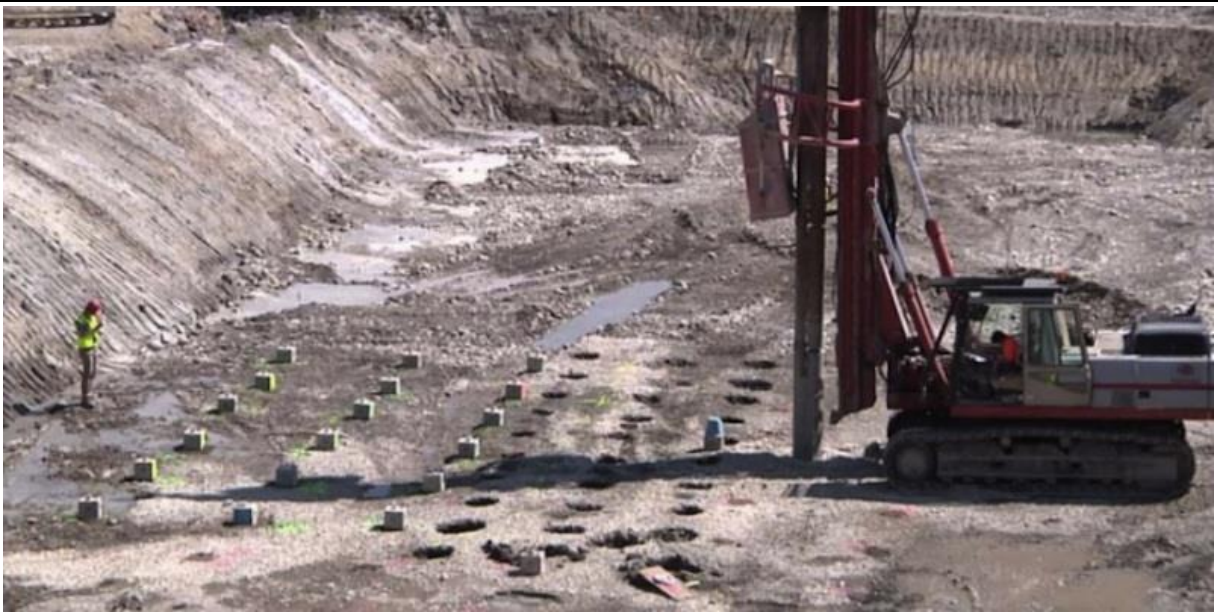
Figure 9 : Sur la droite, une foreuse simule une onde sismique de 50 Hz, au milieu trois rangées de trous de 30 cm de diamètre, 5 mètres de profondeur, espacés de 1,5 m, et sur la gauche des capteurs (des vélocimètres) 14 .
