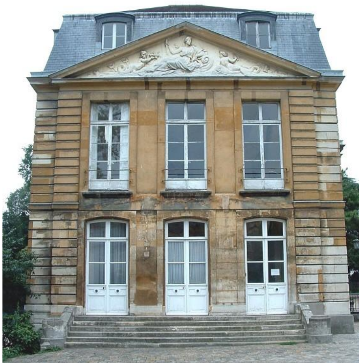
Façade Nord, août 2004 © Jacques Mossot, Struturæ
