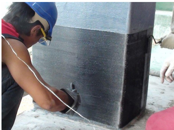
Figure 32 : Chemisage en fibre d'un poteau
