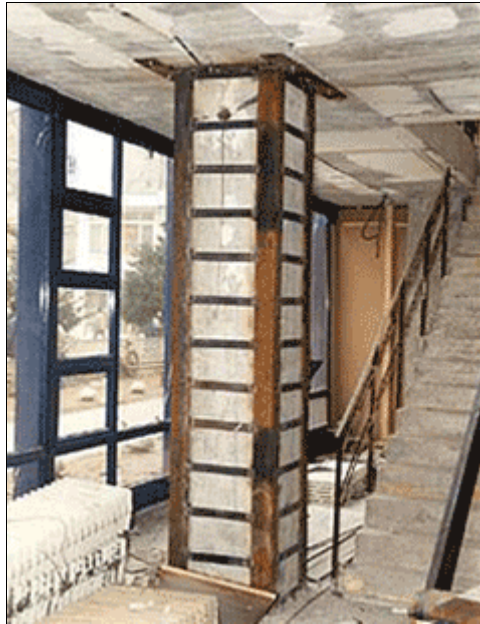
Figure 34 : Chemisage d'un poteau en acier
