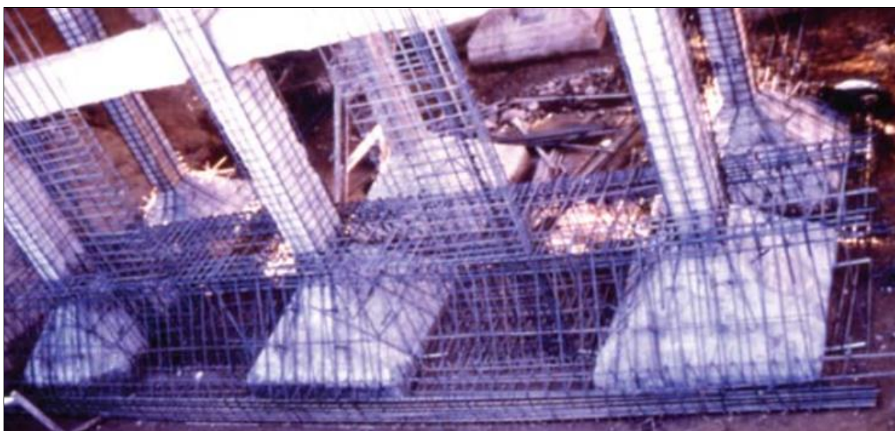
Figure 16 : Nouvelle fondation connectée à celles existantes
