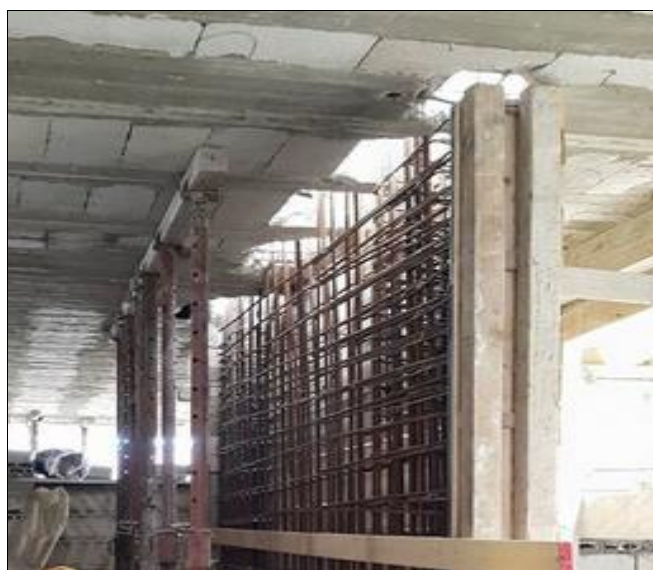
Figure 13 : Exécution d'un voile de contreventement dans une partie existante - Fidar – Liban (Bureau ASSAF)
