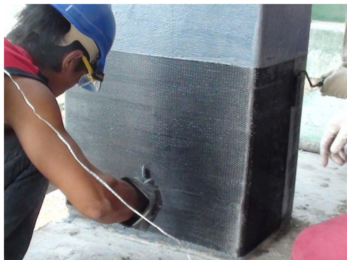
Figure 32 : Chemisage en fibre d'un poteau
