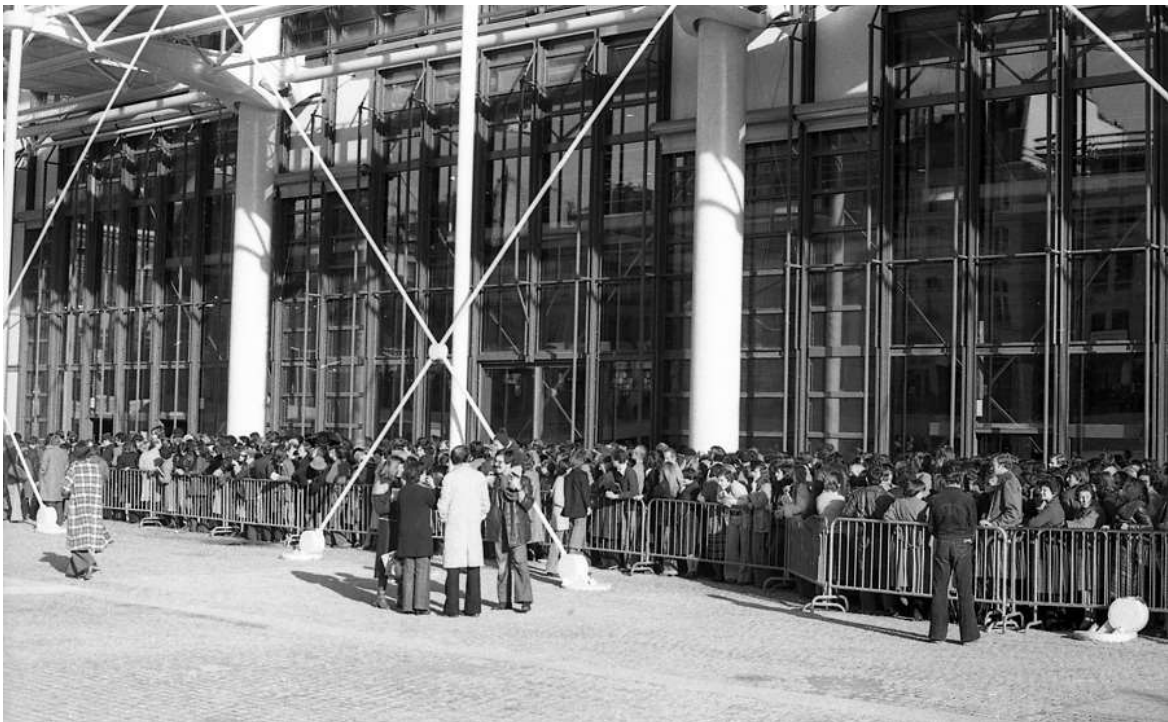
Doc. 21c. Inauguration du Centre Pompidou le 31 janvier 1977
