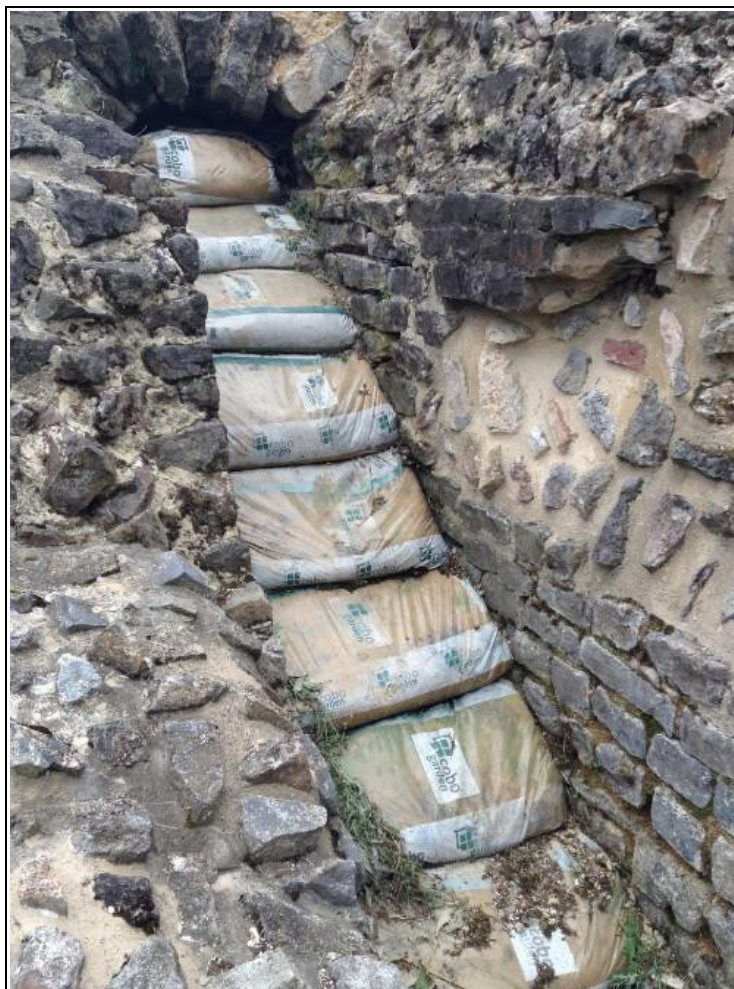
Illustration 41: Bavay : soutien d'une maçonnerie à l'aide de sacs en sable
