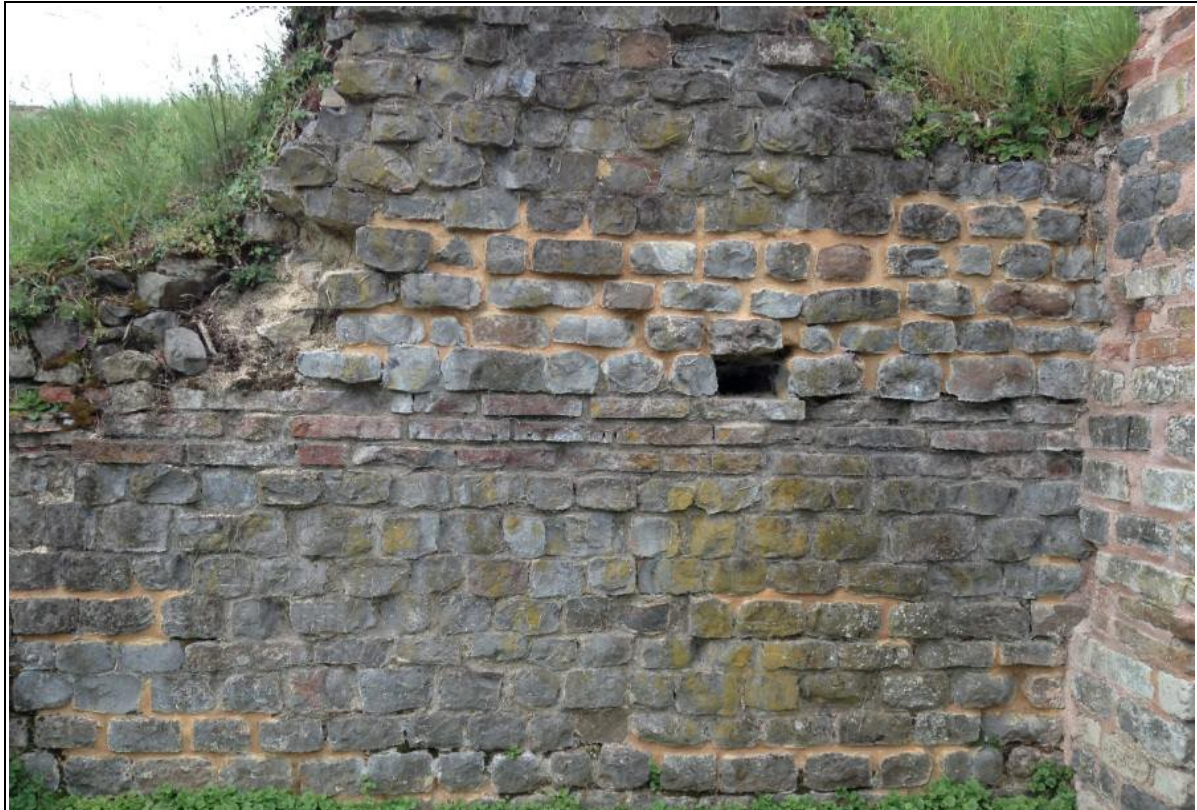
Illustration 37: Bavay : différences de mortiers, chutes de pierre, envahissement de lichens
