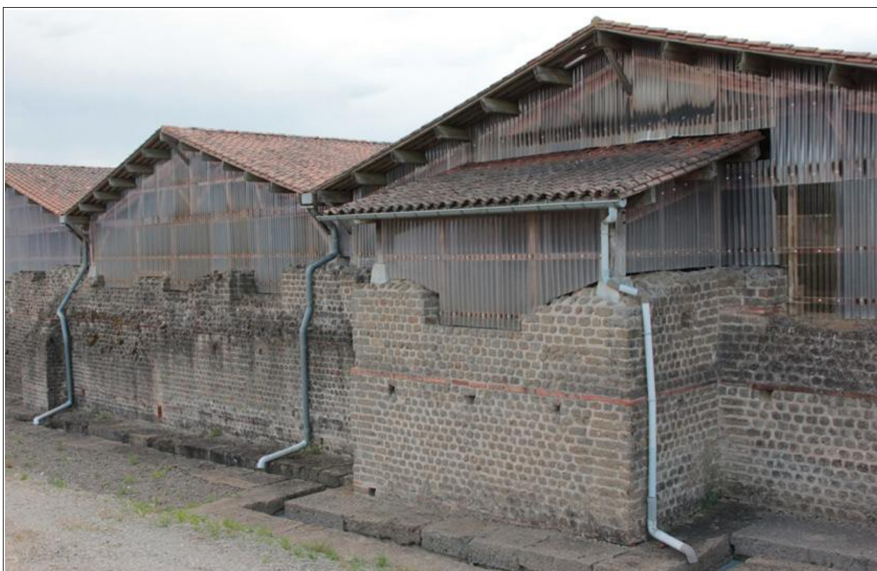
Illustration 25: Chassenon : gestion actuelle de l'eau de pluie (S. Sicard)
