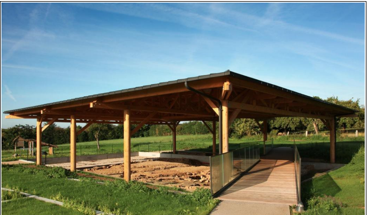
Illustration 13: Vieux : maison à la cour en "u", la toiture-parapluie (G. Wait)
