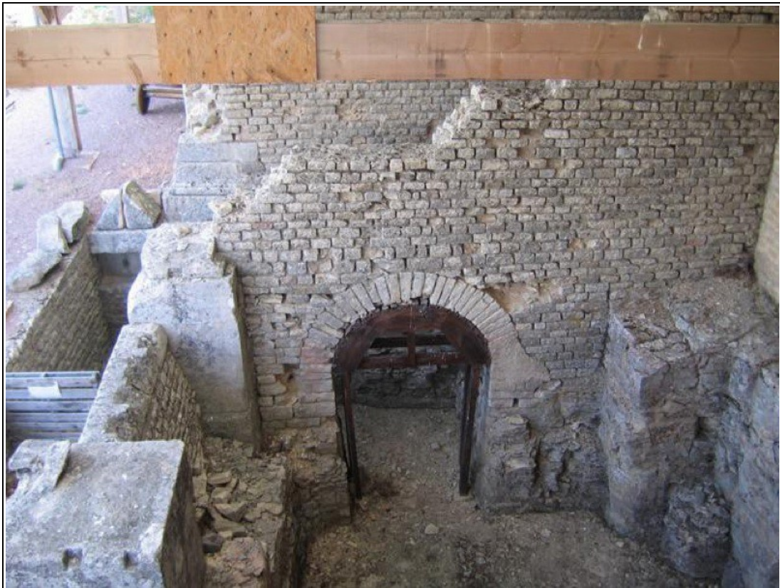
Illustration 17: Alésia : Les étais soutenant l'arcade de la cave du monument à Ucuëtis (brionautes.com)
