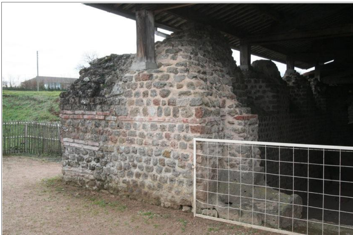
Illustration 24: Chassenon : implantation des plots en béton sur les murs (S. Sicard)
