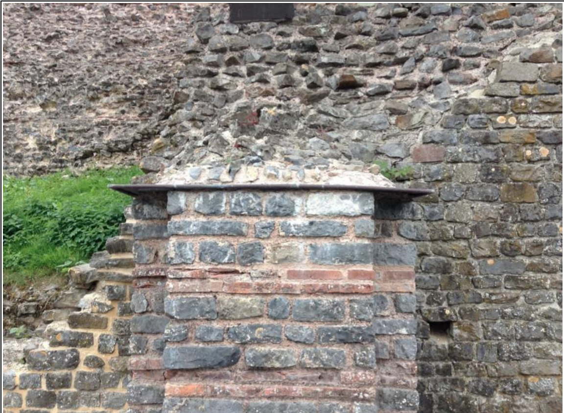
Illustration 43: Bavay : chapeau en cuivre inséré dans une maçonnerie
