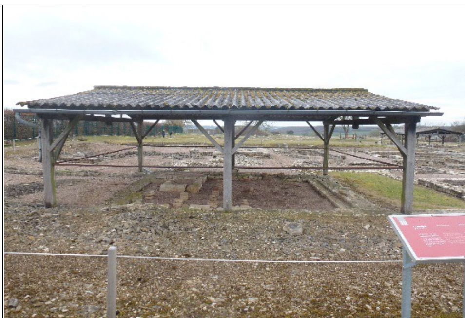
Illustration 20: Alésia : Toiture protégeant les hypocaustes
