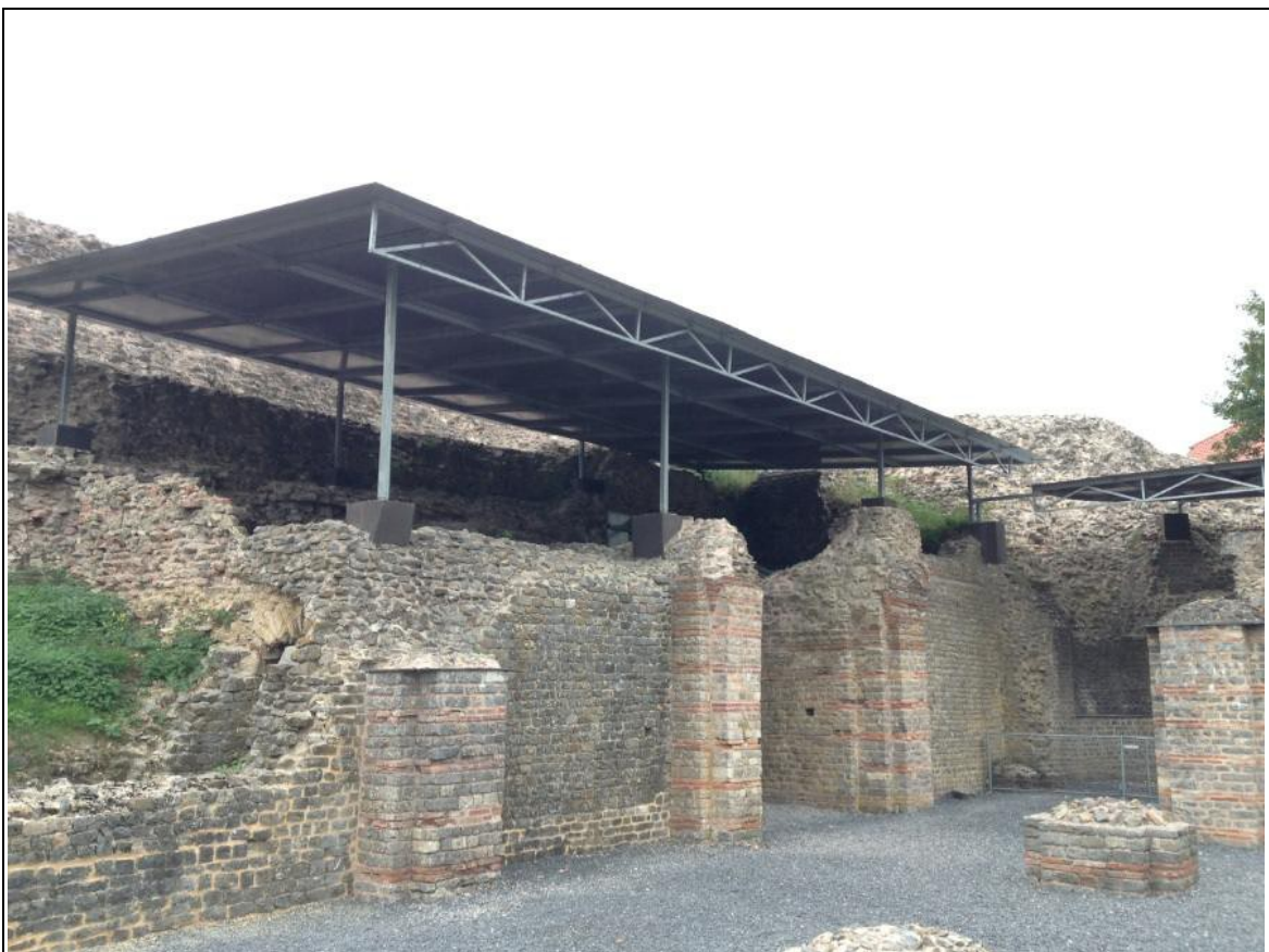
Illustration 44: Bavay : la toiture métallique provisoire
