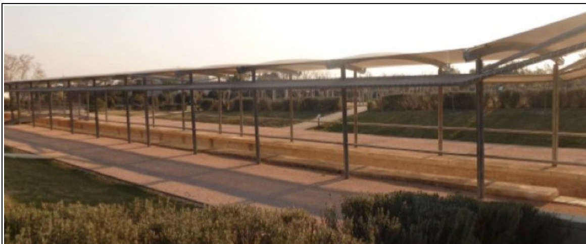
Illustration 51: Caumont : la structure de protection contemporaine du bassin
