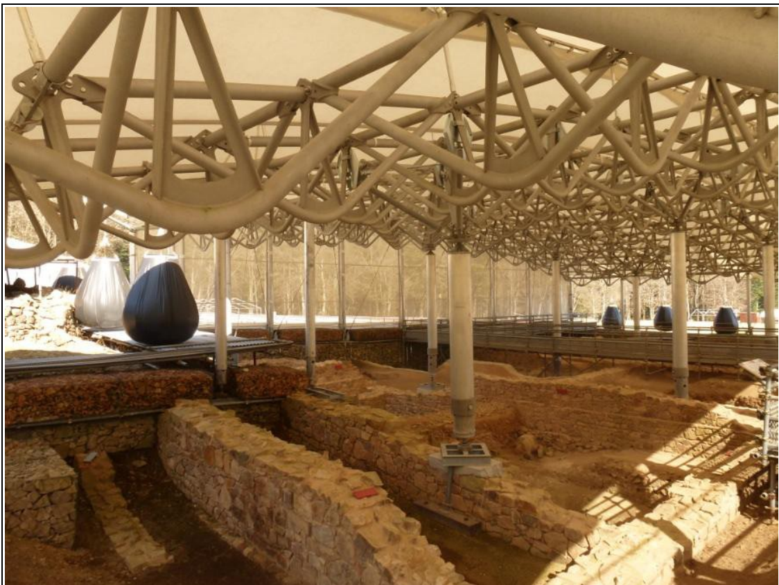
Illustration 34: Bibracte : la structure en modules
