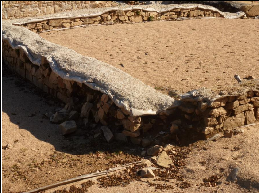
Illustration 31: Bibracte : chape en ciment et bidim
