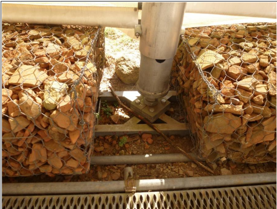
Illustration 35: Bibracte : impact au sol des piliers
