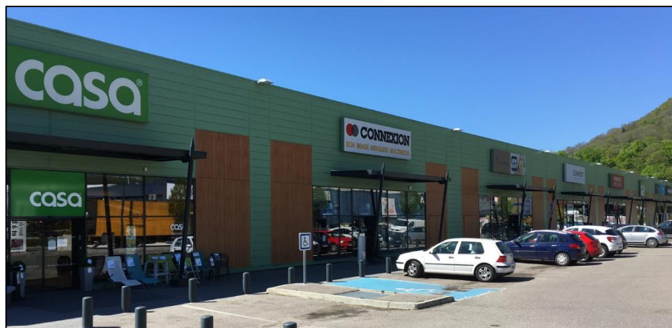
Photo 5 - Secteur « Carré des Blanchisseries » : rue Jean Monnet
