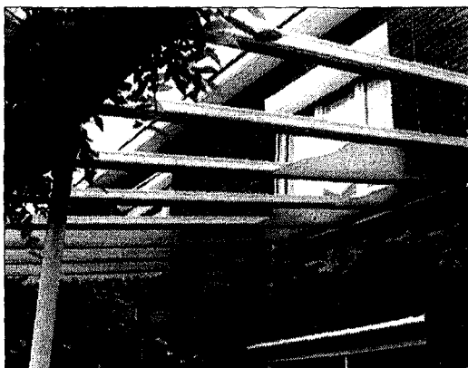
Les vérandas de l'avenue Pasteur à Lambersart ont été comme mitraillées par les grêlons. Certaines ont été cassées.
