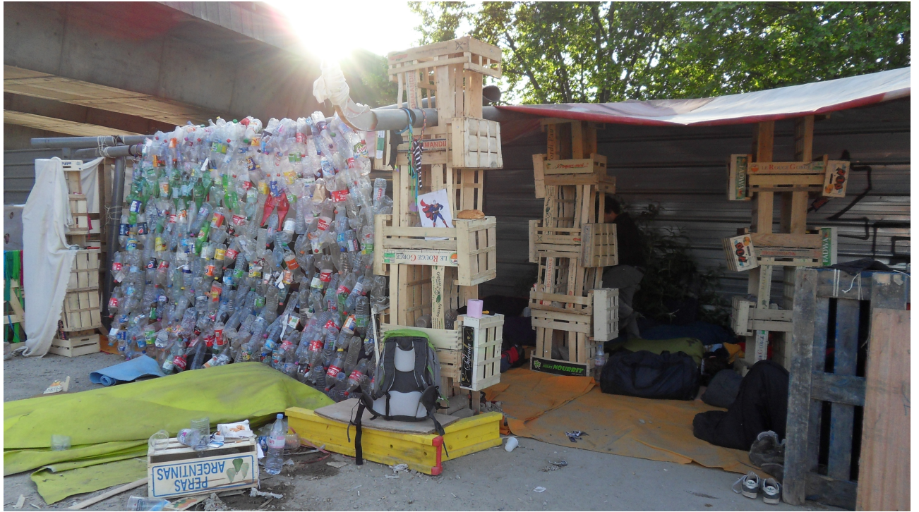
Image 12 - Participation au festival Bellastock «Le Grand Détournement », construction d'une ville éphémère et expérimentale avec le réemploi de déchets, Mai 2012, Ile Saint Denis. Photographie personnelle de notre construction.
