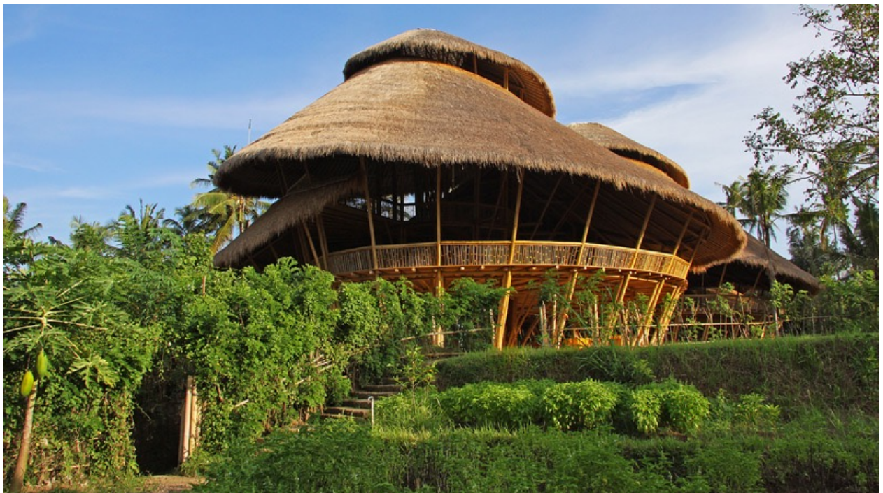
Image 2 - La Green School à Bali, construite en 2007 par PT Bambou est une architecture extraordinaire en bambous et autres matériaux locaux, inspirée de l'architecture traditionnelle. Les bâtiments sont ouverts, favorisant la ventilation naturelle et sont autosuffisants grâce à l'utilisation de panneaux solaires et autres ressources alternatives. L'enseignement est porté sur la nature et le développement de l'enfant.
