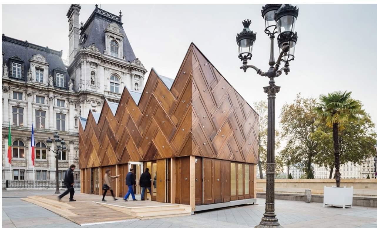
Image 13 - Pavillon devant l'hôtel de Ville de Paris du collectif Encore Heureux, fabriqué à partir de 180 portes réutilisées, fin 2015
