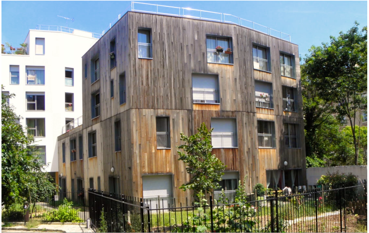
Image 1 - Pension de famille de la rue de Plaisance, Paris 14ème, née en 2001 d'une réflexion d'habitants et de l'association de quartier « Udé ». Accueillant 20 personnes en grandes difficultés - logeant auparavant dans des centres d'hébergement et de réinsertion sociale, 17 studios sont présents avec des pièces communes. Un logement écologique et exemplaire pour réintégrer une mixité humaine au coeur de Paris.
