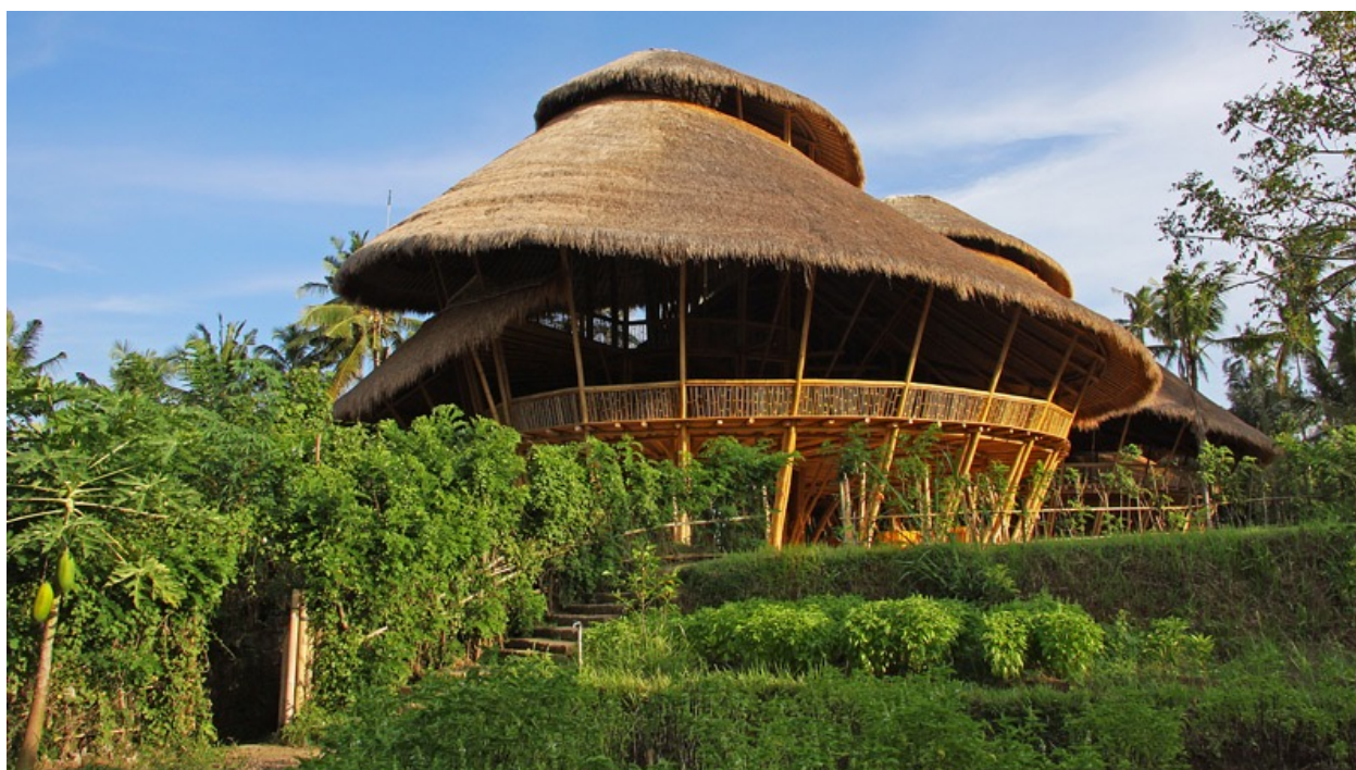
Image 2 - La Green School à Bali, construite en 2007 par PT Bambou est une architecture extraordinaire en bambous et autres matériaux locaux, inspirée de l'architecture traditionnelle. Les bâtiments sont ouverts, favorisant la ventilation naturelle et sont autosuffisants grâce à l'utilisation de panneaux solaires et autres ressources alternatives. L'enseignement est porté sur la nature et le développement de l'enfant.
