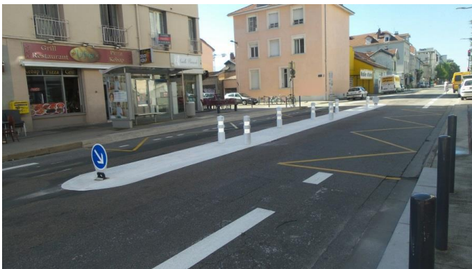
Figure 20 Photographie de la mise en place d'un terre-plein ayant pour but d'apaiser la rue Ampère par Pauline Desmedt
