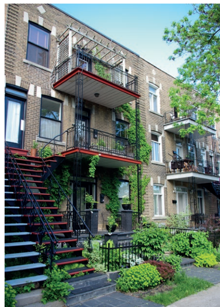
Triplex avec escalier extérieur
